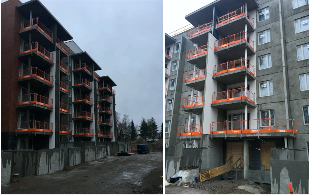
Kuva 63. Kuvia kohteen julkisivuista. Oma dokumentti.
