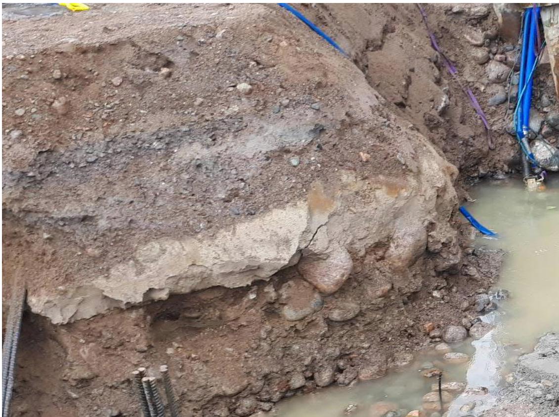
Kuva 4. Pohjaveden alentamista kaivannon pohjalta [35.].
