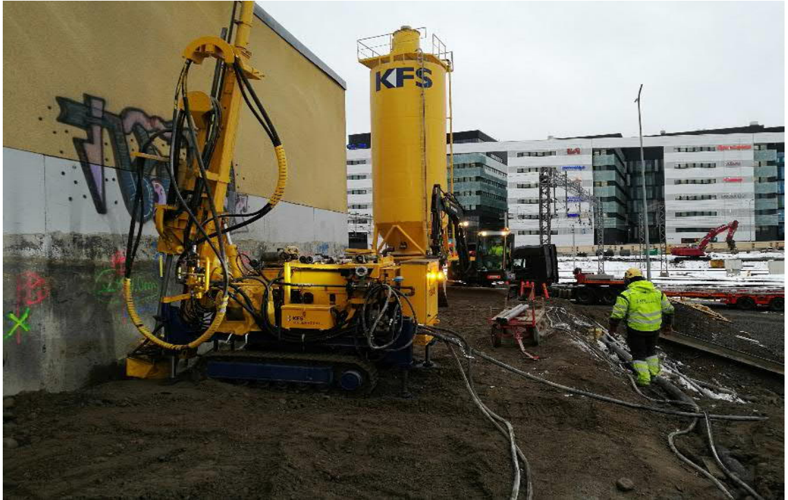
Kuva 11. Suihkupaaluseinän suihkuinjektointi [39].
