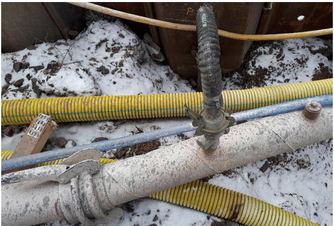
Kuva 9. Siiviläputken ja runkoputken liitos [35.].
