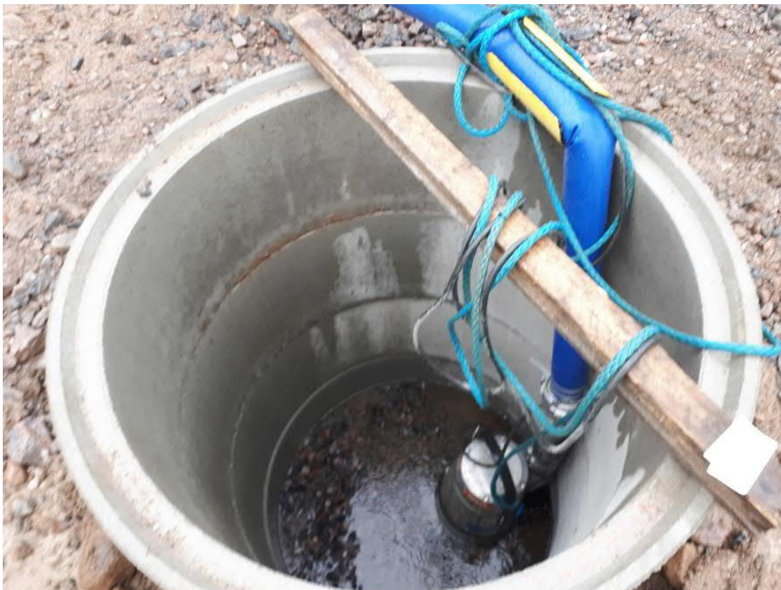
Kuva 5. Betonirenkaista tehty syväkaivo [35].
