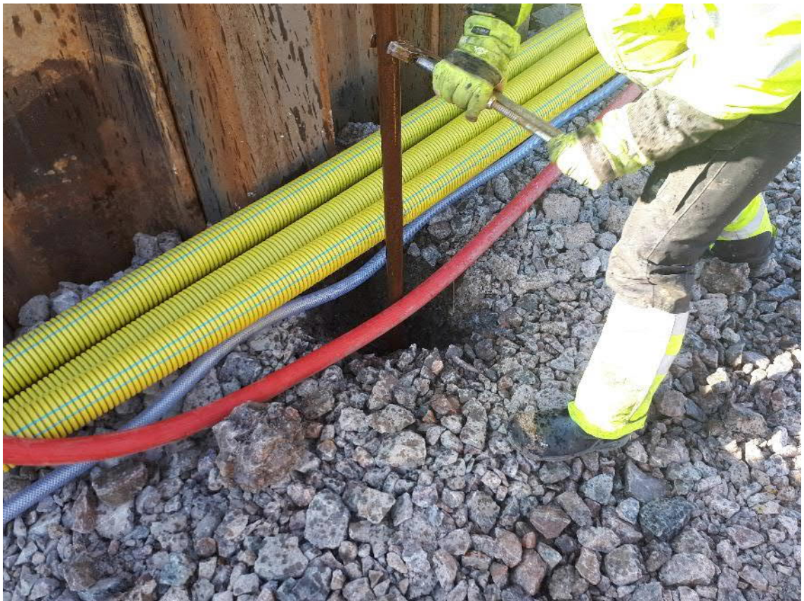
Kuva 7. Siivilä kärkiputkien asentaminen [35.].
