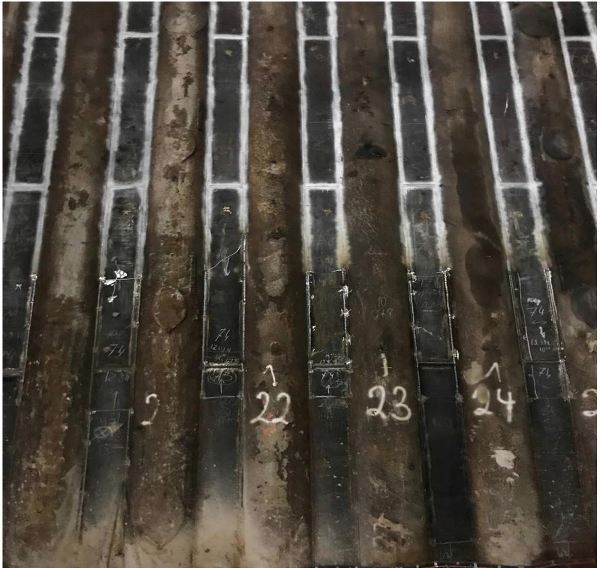
Kuva 13. Porapaaluseinä [42.]
