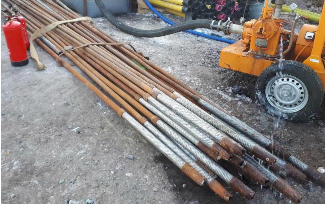
Kuva 10. Kuvassa on siiviläkärkiputkia sekä niiden asentamisessa käytettävä huuhtelupumppu [35.].
