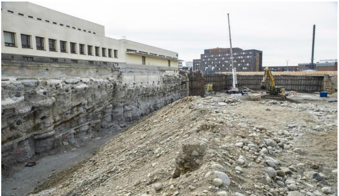
Kuva 12. Valmis suihkupaaluseinä [40].
