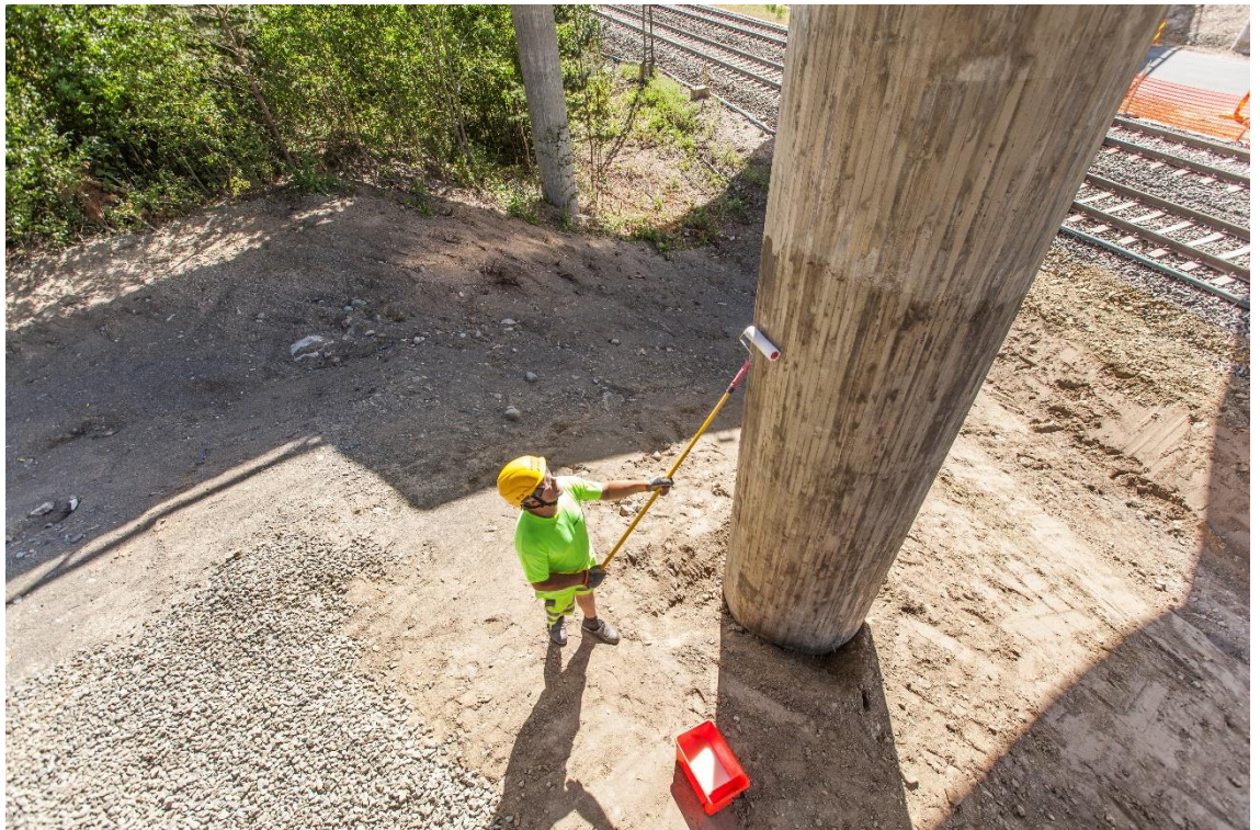
Kuva 5. Välituen impregnointia telalla (Destia Oy, 2015)
