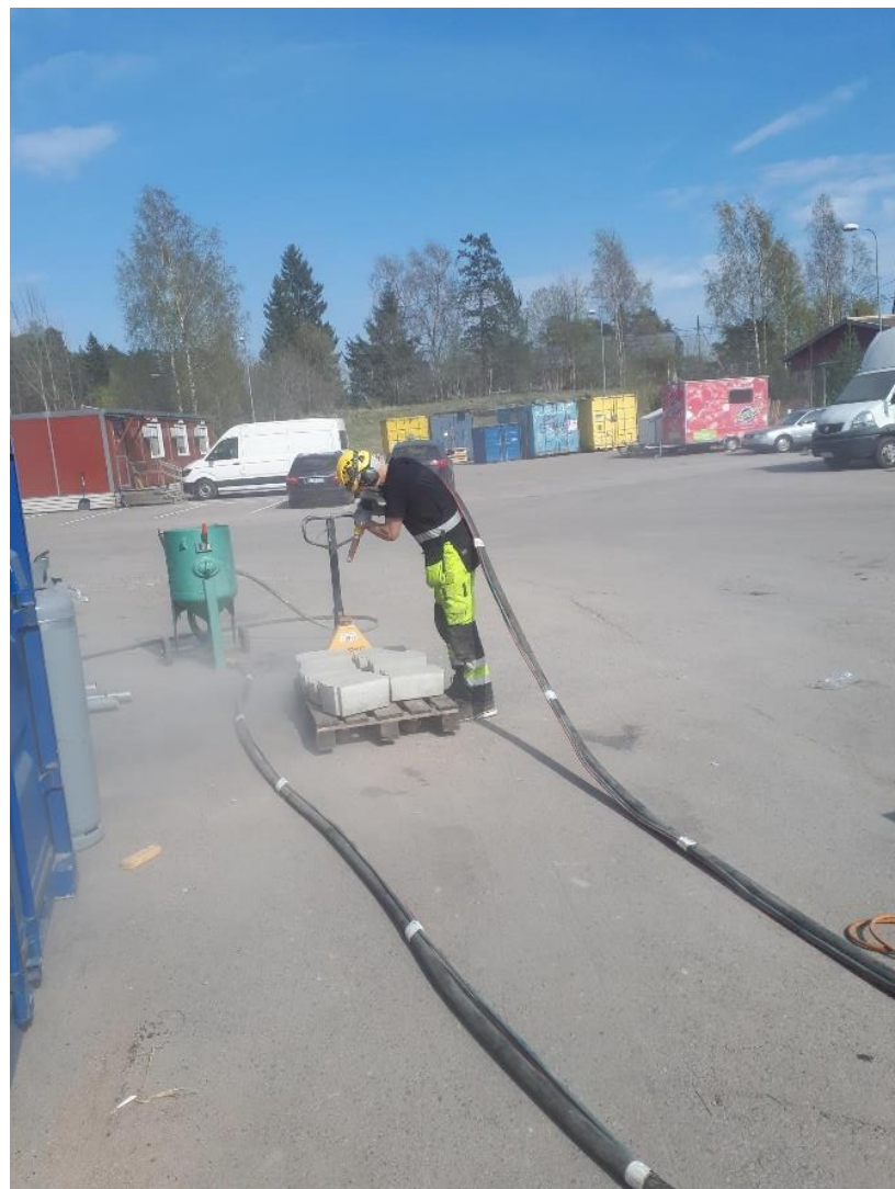
Kuva 17. Betonin hiekkapuhallus
