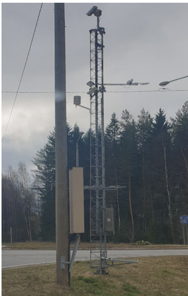
Kuva 2. Tiesääasema, jossa myös kelikamera. Kantatie 73 Vieki, Lieksa. (ROSSINEN 2019-05-13).
