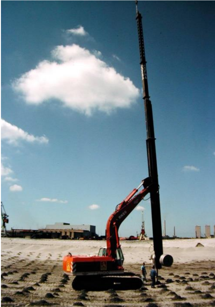
KUVA 6. Geotekstiililiuskojen asennusta (5)
