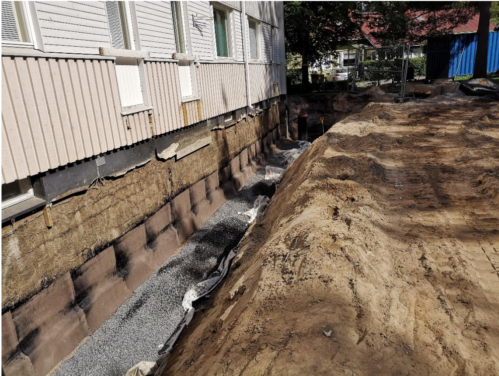
KUVA 7. Perusmuurin vedeneristys bitumikermillä (1)
