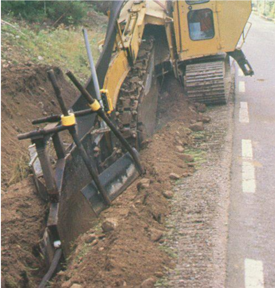
KUVA 4. Hydradrain -pystysalaojamaton asentamista (4)
