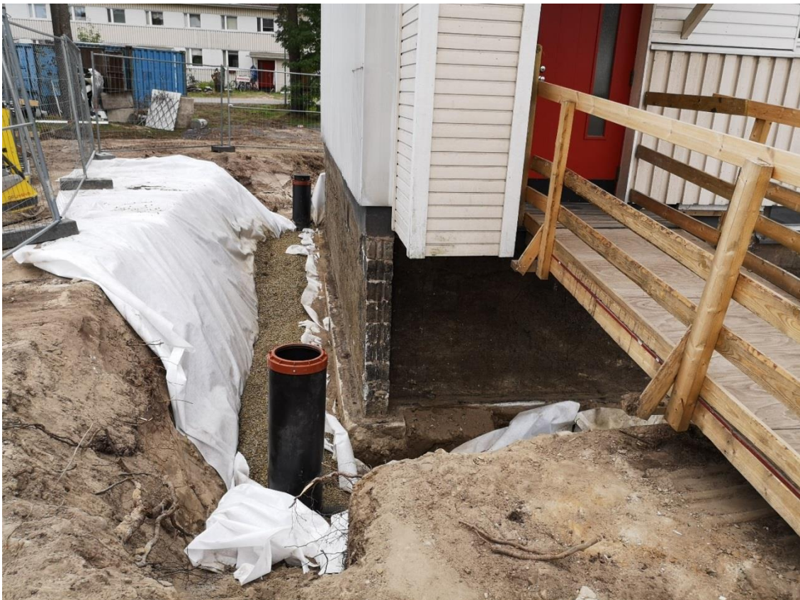
KUVA 13. Maanrakennuskangas pitkänä pystysalaojaa varten (1)
