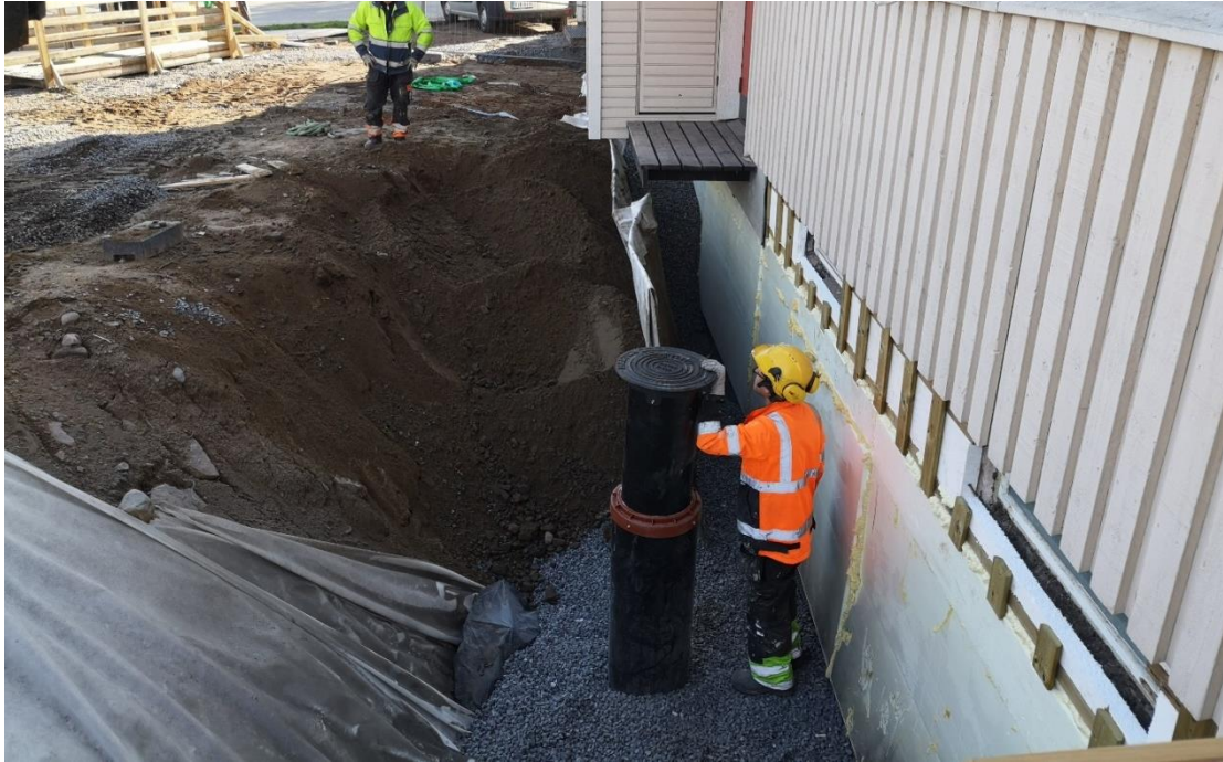
KUVA 9. Pystysalaojitus salaojasepelillä käyttäen metallilevyä (1)
