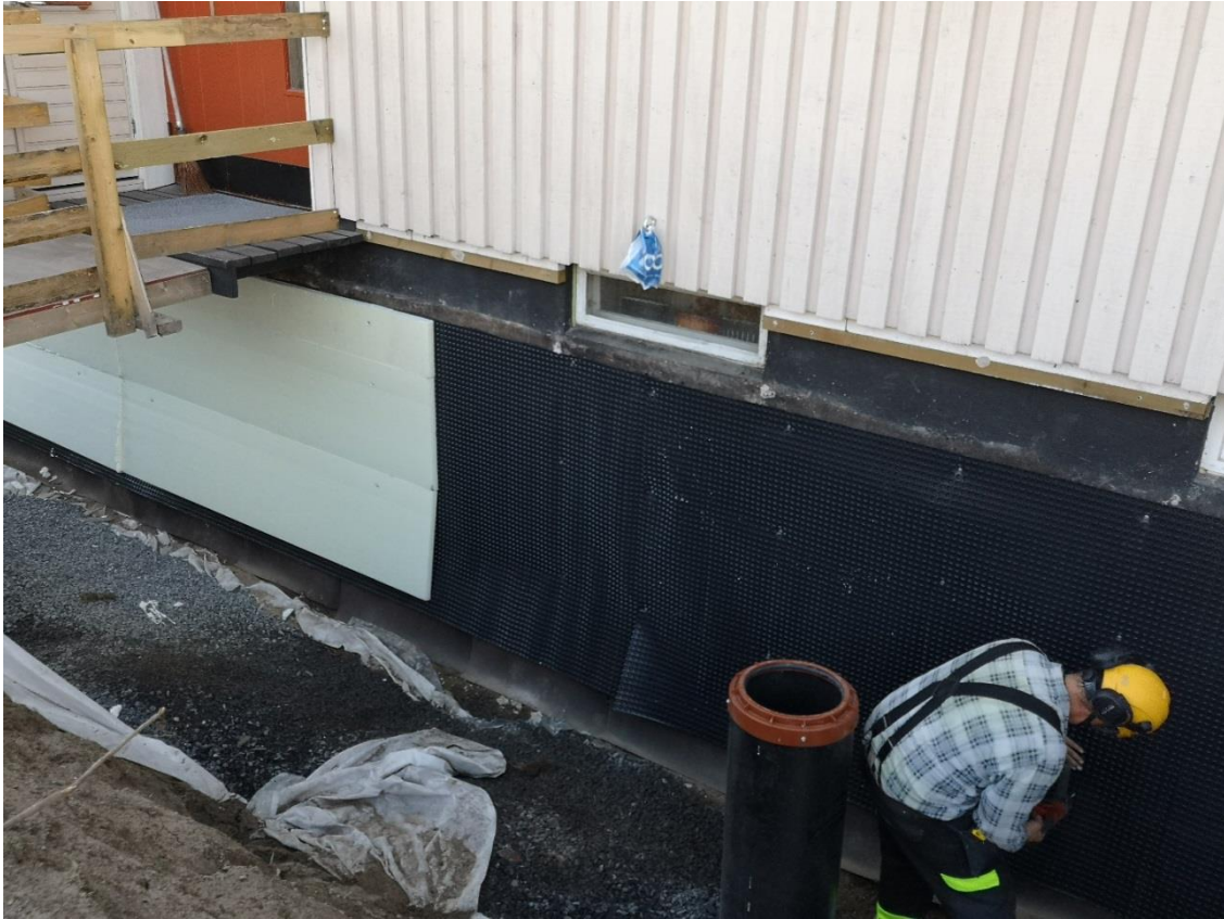
KUVA 8. Perusmuurin vedeneristys perusmuurilevyllä ja perusmuurin lämmöneristys (1)
