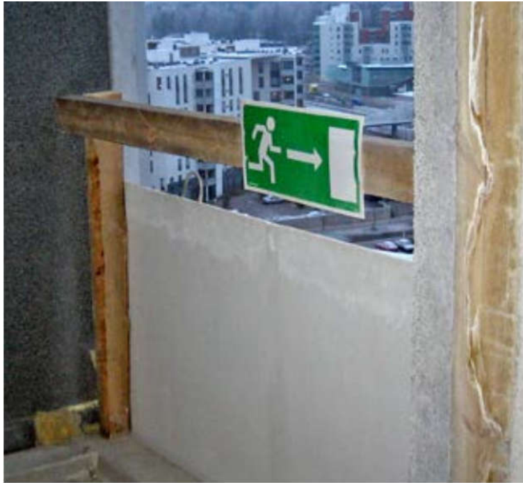
Kuvio 7. Poistumistiet merkitään selkeästi työmaalla (RATU C2-0454 2017.)
