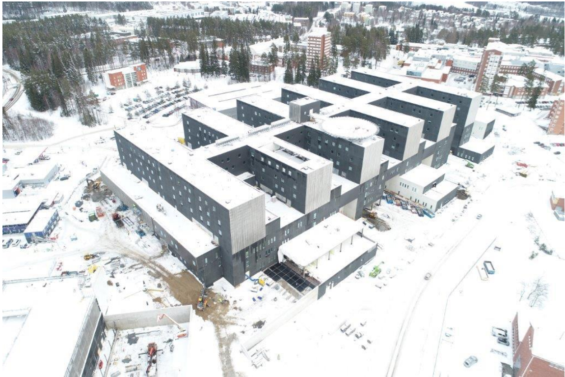
Kuvio 1. Rakennustyömaan tilanne tammikuussa 2019 (Työmaan tilanne 2019).
