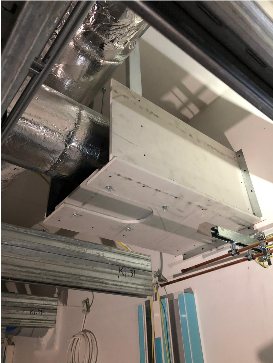
Liite 11. Tarkastusluukun suojaus toteutettuna.
