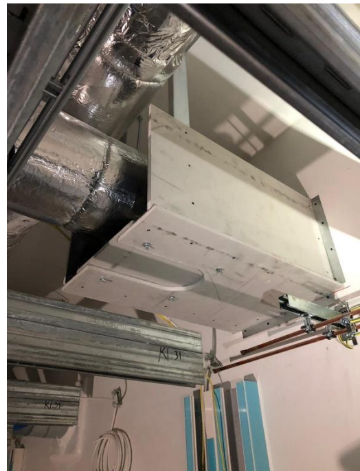
Kuvio 23. Tarkastusluukun suojaus toteutettuna.
