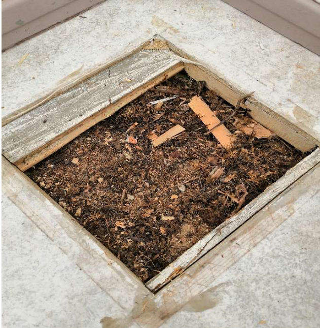
Kuva 3. Alapohjan rakenneavaus.
