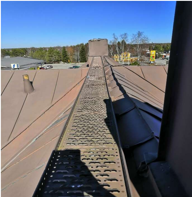
Kuva 18. Kattokulkusillat.
