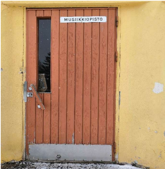
Kuva 24. Musiikkiopiston ovi ulkopuolelta.
