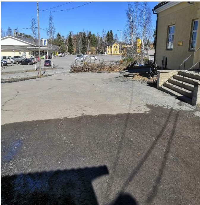
Kuva 30. Etupuolen piha-alue asfaltti.
