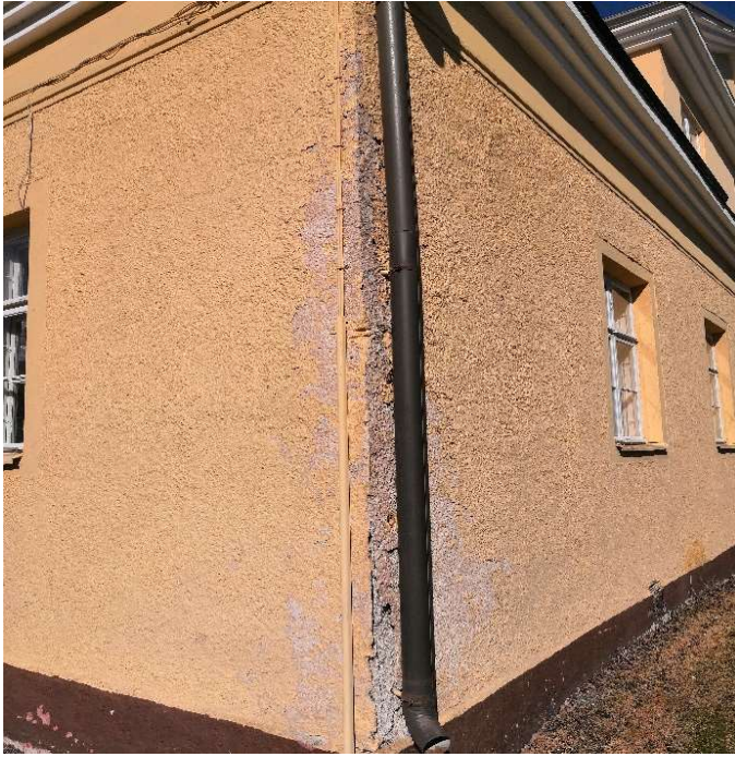
Kuva 7. Luoteiskulman julkisivuvaurio.
