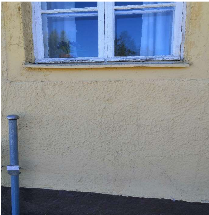
Kuva 8. Kakkoiskulmassa halkeamia julkisivuissa.
