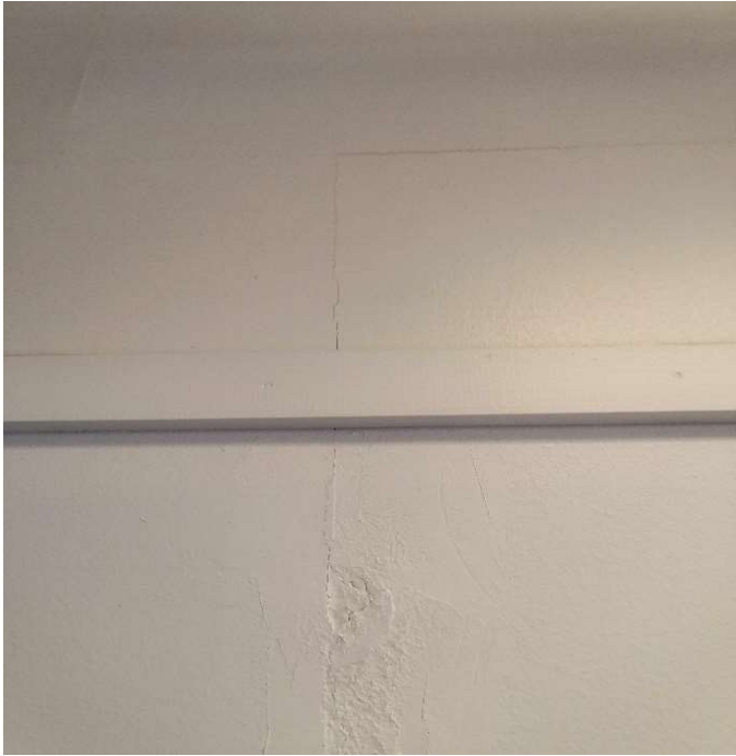
Kuva 5. Lastulevyn halkeamia.
