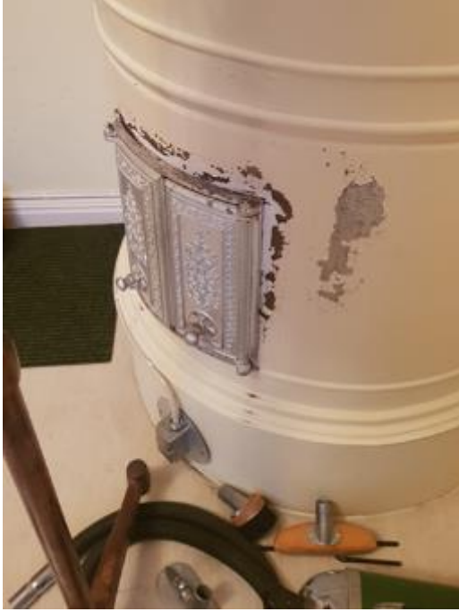
Kuva 26. Pönttöuunin maali on hilseillyt kuumuuden vuoksi.
