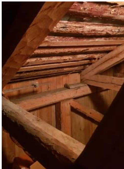
Kuva 21. Rakenteet ovat hyvässä kunnossa.
