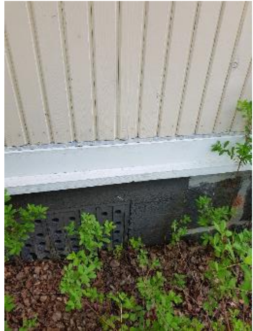
Kuva 6. Suojapelti suojaa alapuuta.
