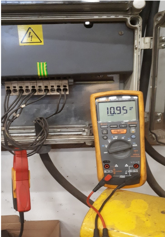
Kuva 26. Virran mittaus
