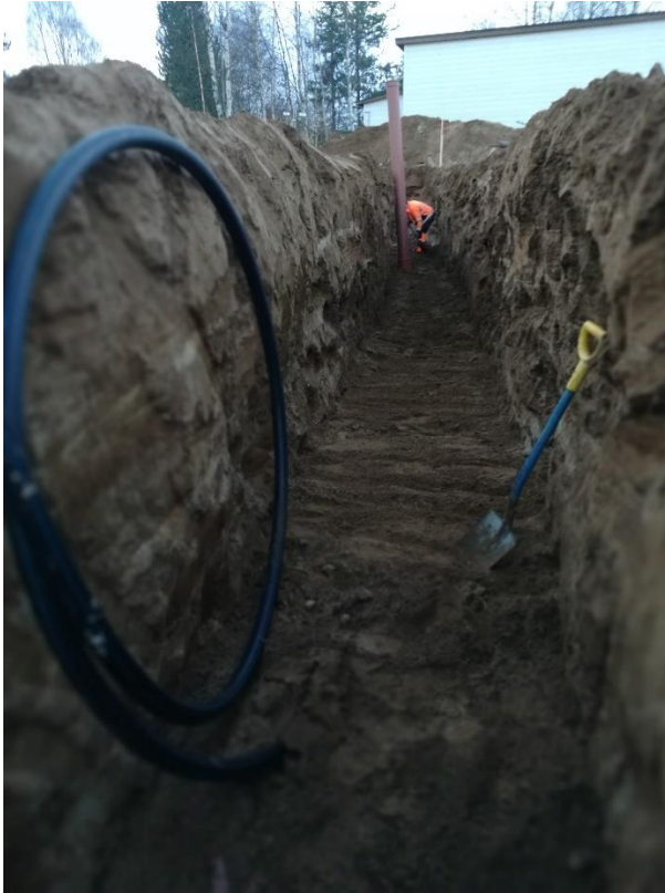
Kuvio 1. Vesijohto- ja viemärikaivanto
