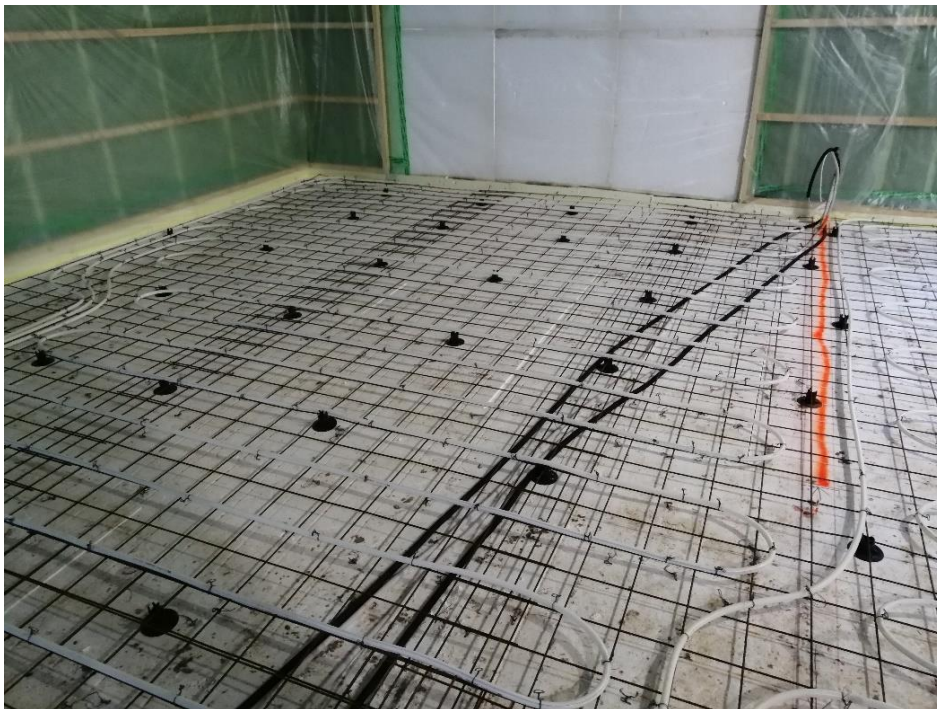
Kuvio 7. Alapohja eristettynä ja raudoitettuna
