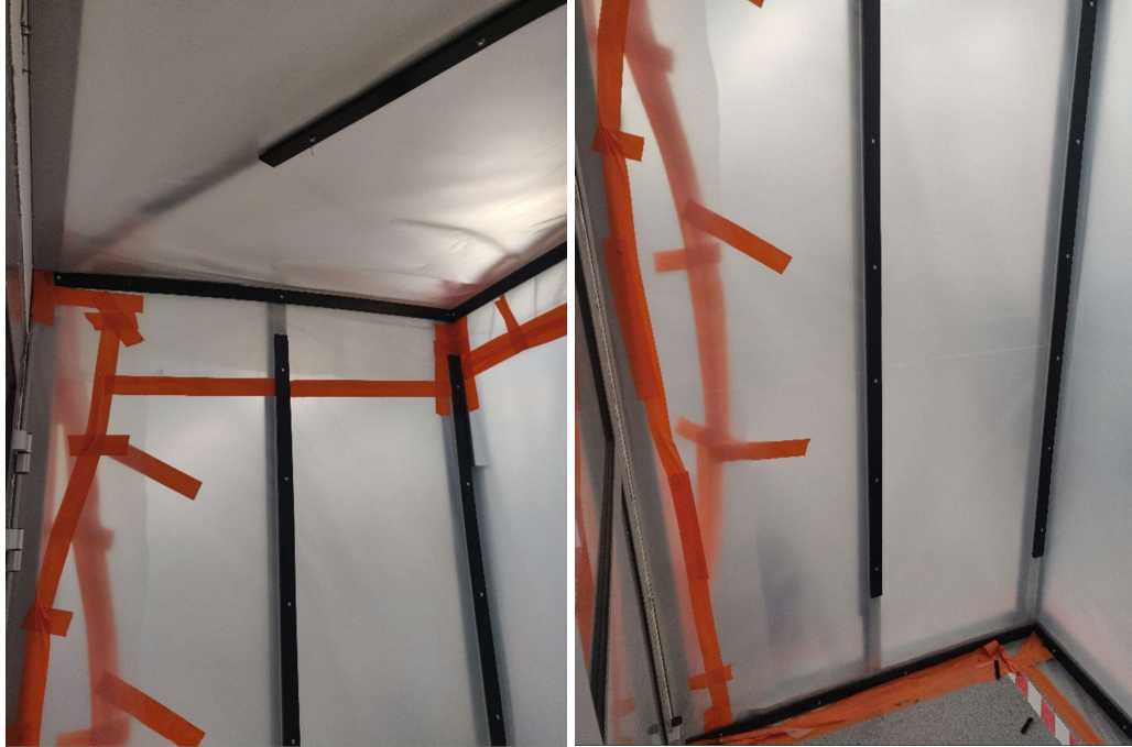
Kuva 12. Tuotantotilojen ja työmaan väliset suojaseinät.
