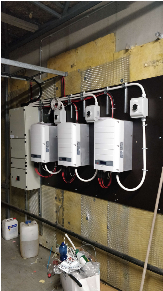
Kuva 6. Aurinkosähköjärjestelmän osakokoonpano.
