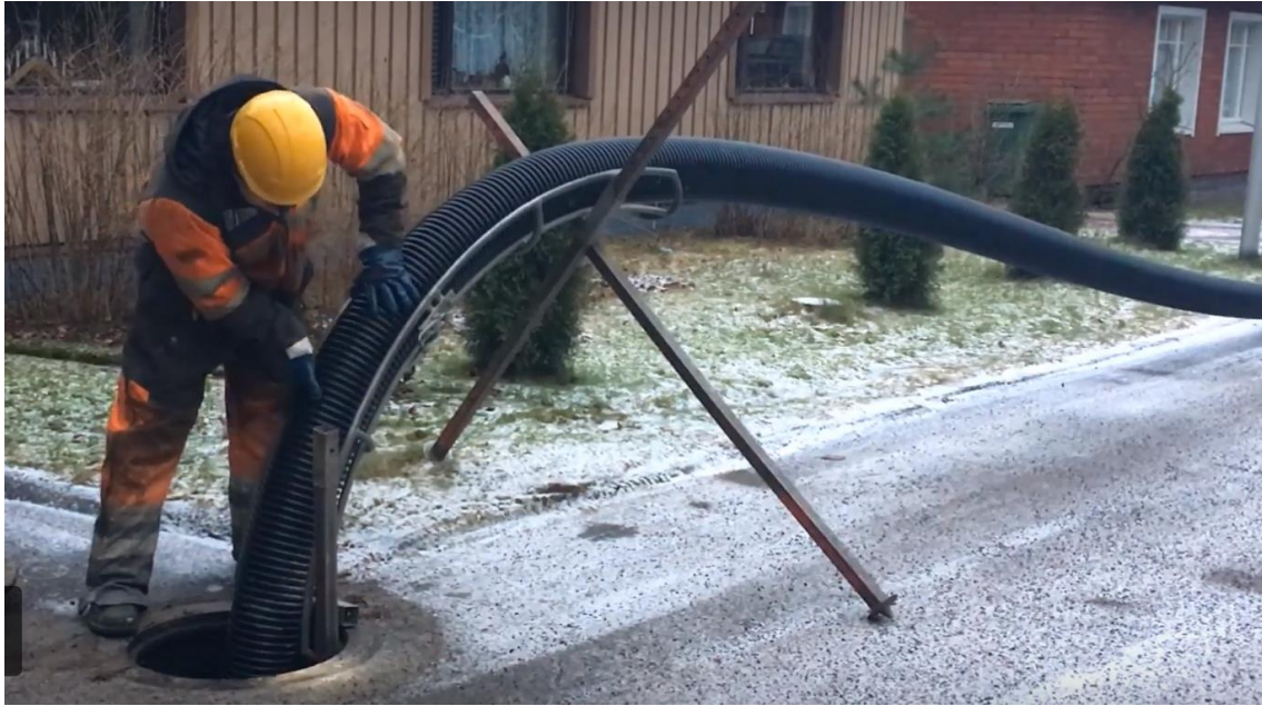
KUVA 1. Flexiputken sujutus kaivoon (6)
