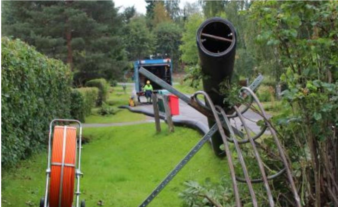
KUVA 2. Putkeen asennettu vetopää (5)
