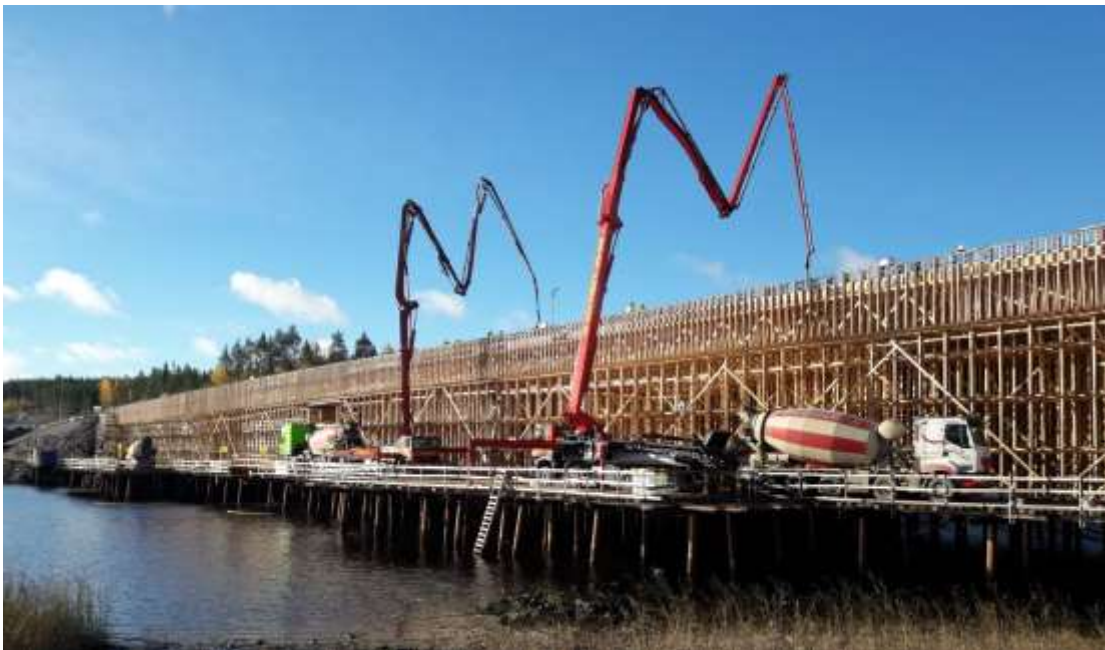
KUVA 2. Betonin pumppaus- ja kuljetuskalustoa työsiällä.
