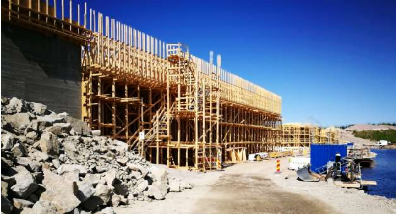
KUVA 1. Tärttämäen sillan telineet rakennusvaiheessa.
