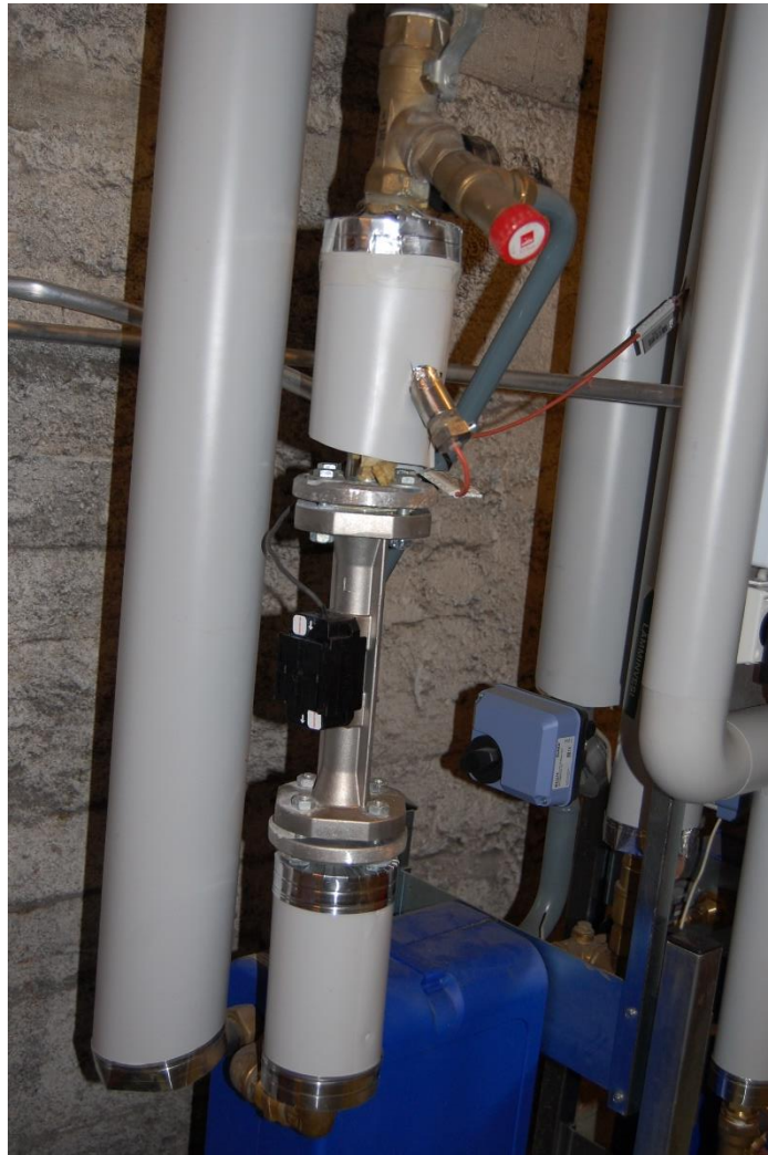
Kuva 4. Virtaus- ja lämpötila-anturi kohteessa 1
