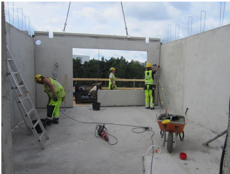
Kuva 8. Elementtiasennusta Rakuunapuistossa.
