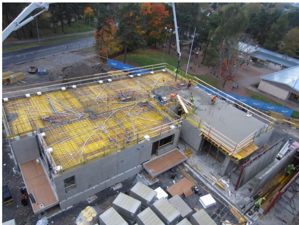
Kuva 6. Holvin betonointia, Rakuunapuisto.
