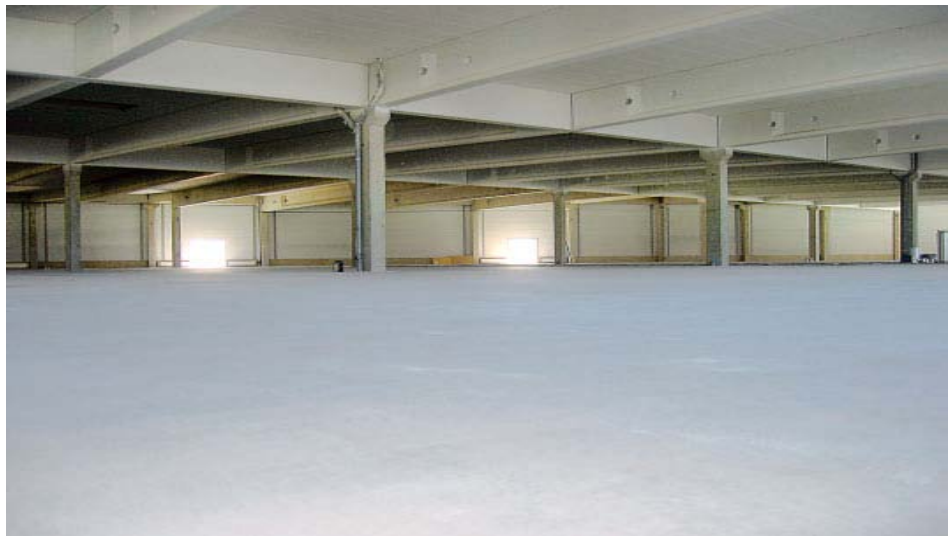
Kuva 29. Suuren hallirakennuksen saumaton maanvarainen alapohja./6/
