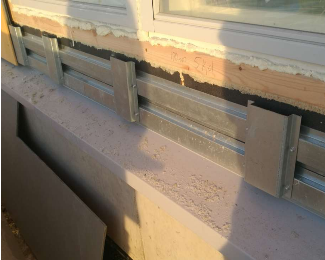
KUVA 3. Ikkunan alapuolinen ristikoolaus
