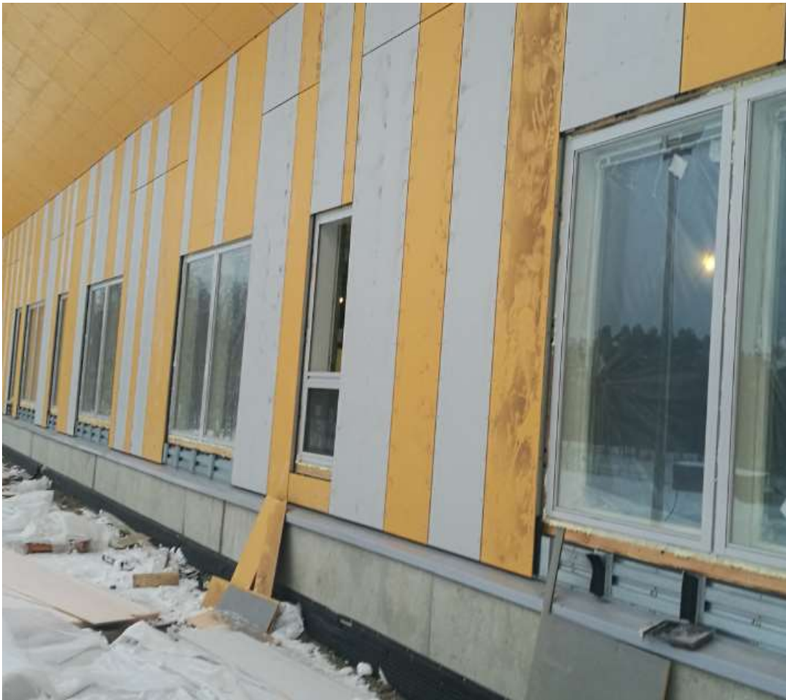
KUVA 4. Osittain valmis seinälevytys.
