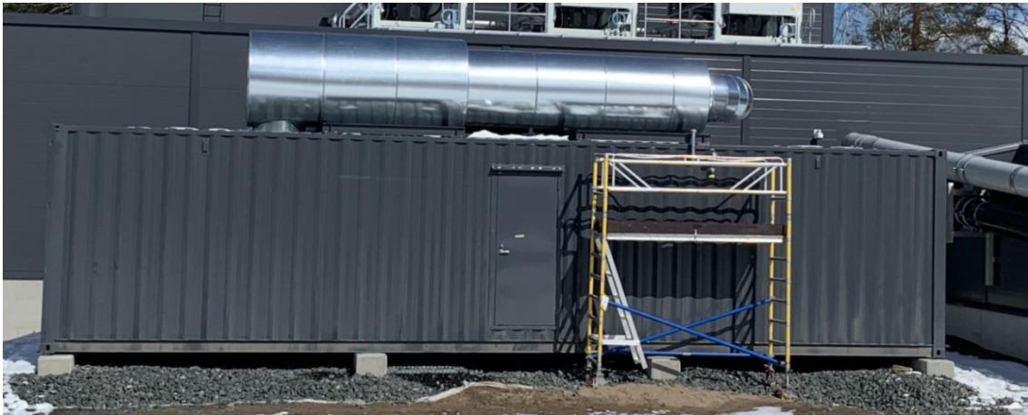
KUVA 11. Dieselgeneraattorikontti kohteessa
