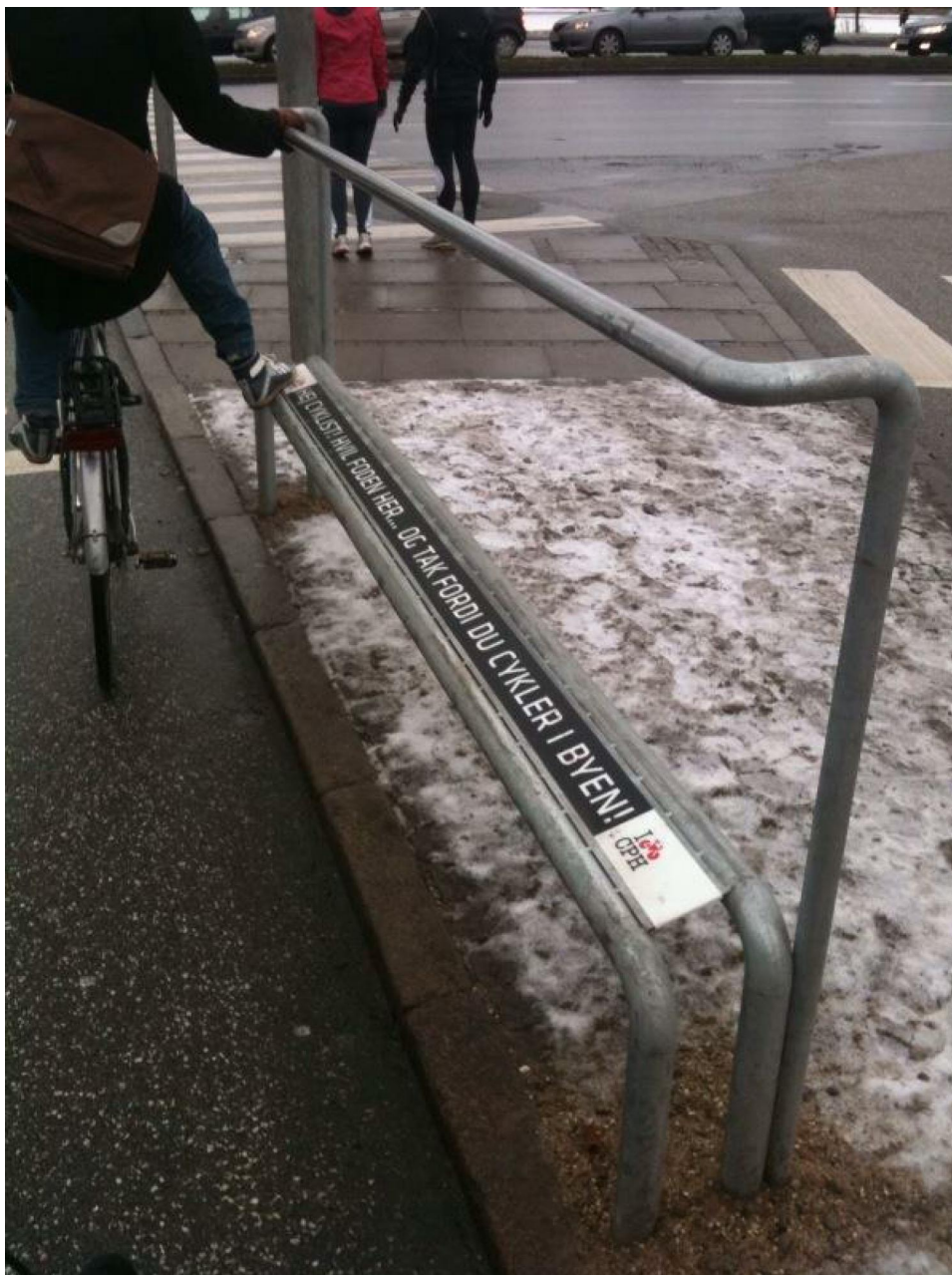
Kuva 26. Pyöräilijän tukikaide - footrest (Colville-Andersen, 2010)
