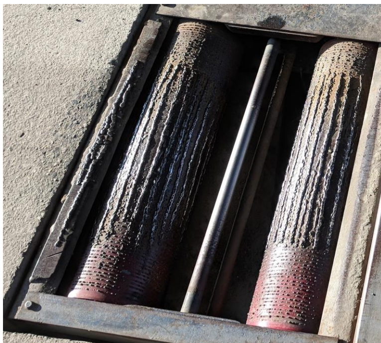
Kuva 10. Lähes koko pituudelta käsin hitsattu jarrudynamometrin tela. Huomioitavaa on, että pyöröhitsattua telaa on hitsattu poikkeuksellisesti pituussuunnassa eikä alkuperäisen kulutuspinnan suuntaisesti. Moitittavaa on myös, että hitsijälki ei ole tässä tapauksessa edes suora. MAK Tarkastus Oy.
