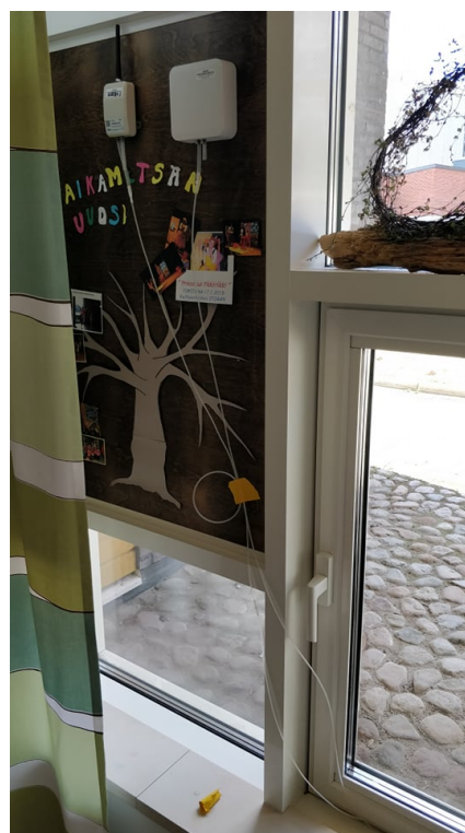
Figur 24. Två olika mätare som mäter tryckskillnaden över klimatskalet. Bild: Simon Wickström, 12.04.2019.
