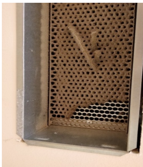
Figur 2. Smutsig frånluftsventil i en skola i Sibbo. Bild: Simon Wickström, 25.5.2018.
