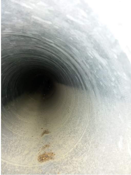
Figur 6. Pollen i en tilluftskanal. Ingå hälso-station. Bild: Rasmus Hellström, 04.07.2018.
