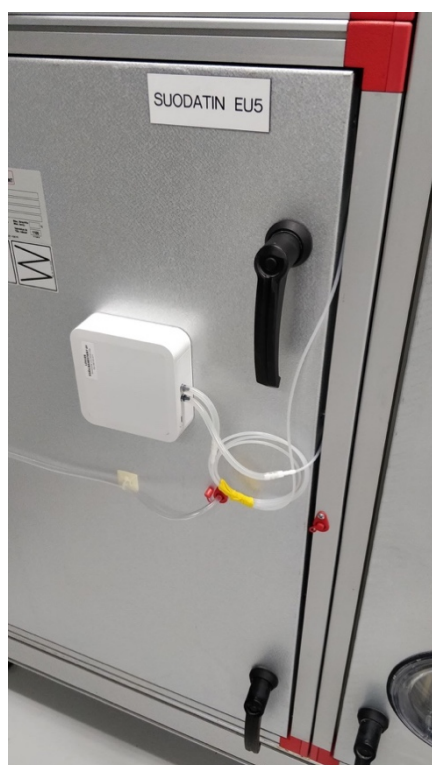
Figur 23. Tryckskillnadsmätare över tilluftsfilter. Bild: Sebastian Alfthan, 12.04.2019.
