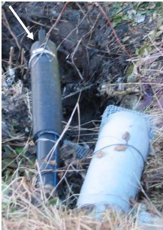
KUVIO 13. Toisessa kohteessa käsitellyn jäteveden näyte saatiin otettua purkuputken päästä
