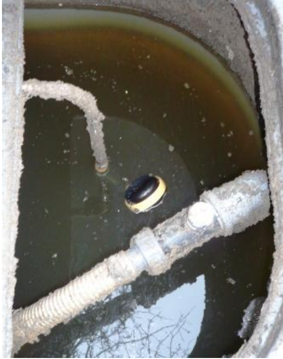
KUVIO 14. Suoraan kivipesään johdettavan jäteveden takia käsitellyn jäteveden näyte tuli ottaa prosessisäiliöstä
