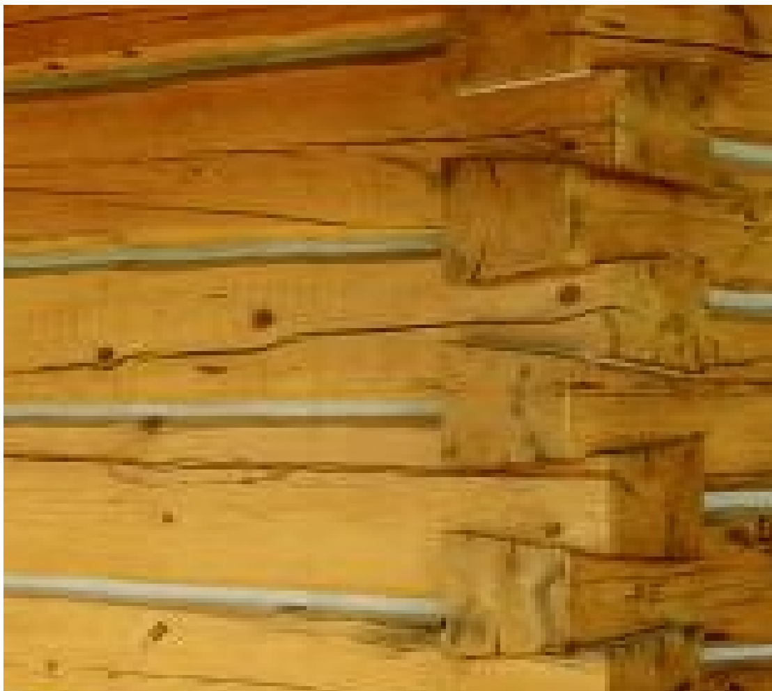
KUVIO 4: Kanadalaisen hirsirakentajakoulutuksen mukainen pääasiassa nurkistaan toisiinsa sovitetun puun ja saumausaineen liittorakenne, Chink Style. (Manipuloitu detalji kuvasta http://www.kealeyhackaberryloghomes.com/wp-content/uploads/2007/12/bc_timber_21.thumbnail.jpg )
