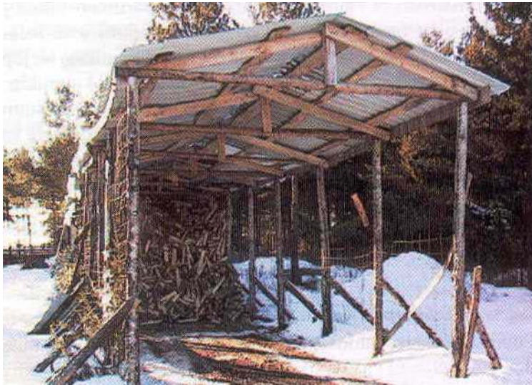
KUVA 19. Polttopuukatoksen suunnittelussa on hyvä huomioida, että kuormaus saadaan suoritettua koneellisesti (Pikkujämsä 2001, 11).
