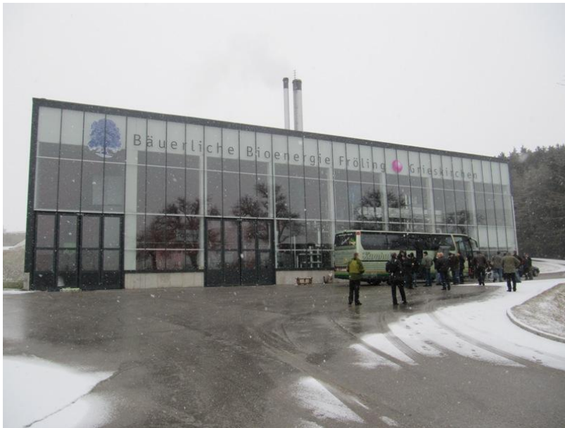
KUVIO 6. Lämpölaitoksen julkisivu
