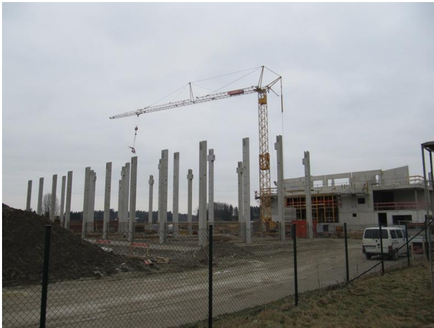
KUVIO 3. Rakenteilla oleva 3 MW:n lämpövoimalaitos
