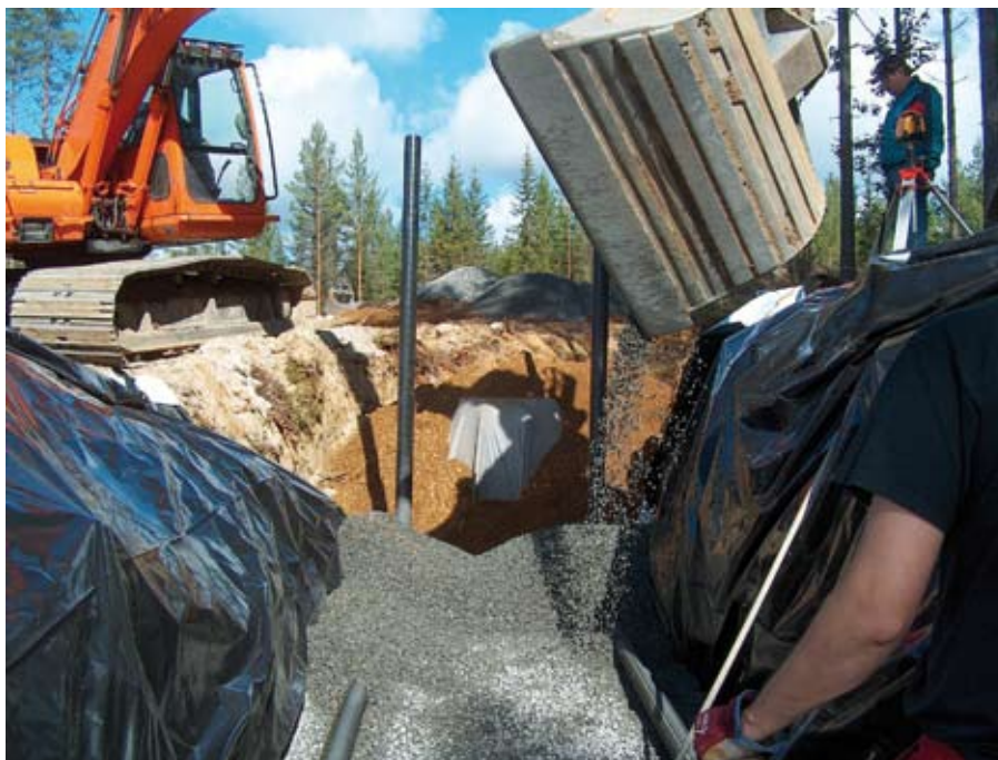
Maasuodattamo valmistuu kerros kerrokselta työnäytöksessä. Kuva: Heli Tammelin.
