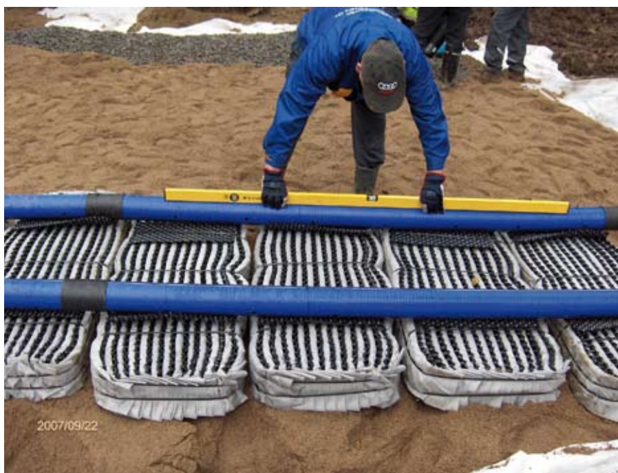
Työnäytöksissä esiteltiin erilaisia järjestelmiä, kuvassa vaakavirtausmaasuodattamon laitteistoa. Kuva: Nina Pimiä.
