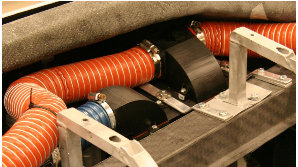
Kuva 13. Putkiliitokset tehtiin suurimmaksi osaksi rengaskiristimillä
