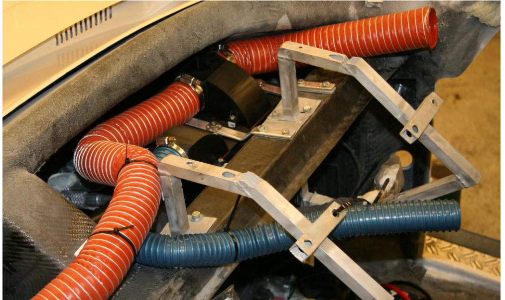
Kuva 18. Mittaustilanteessa ilmavirtaa mitattiin sijoittamalla sensori putken suulle
