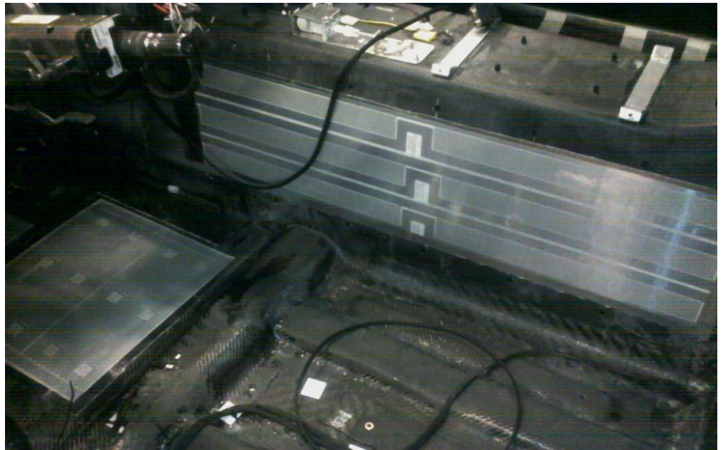
Kuva 15. Lämmityskalvot lattiassa ja keskitunnelissa
