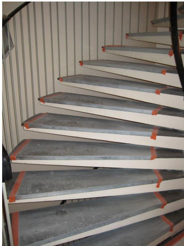
Kuva 19. Portaat kannattaa suojata huolellisesti 0,6 mm:ä vahvalla pellillä
