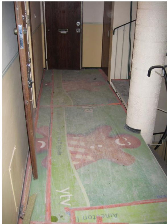
Kuva 16. Vanhat mainoslevyt soveltuvat hyvin lattioiden ja porraskäytävien suojaukseen
