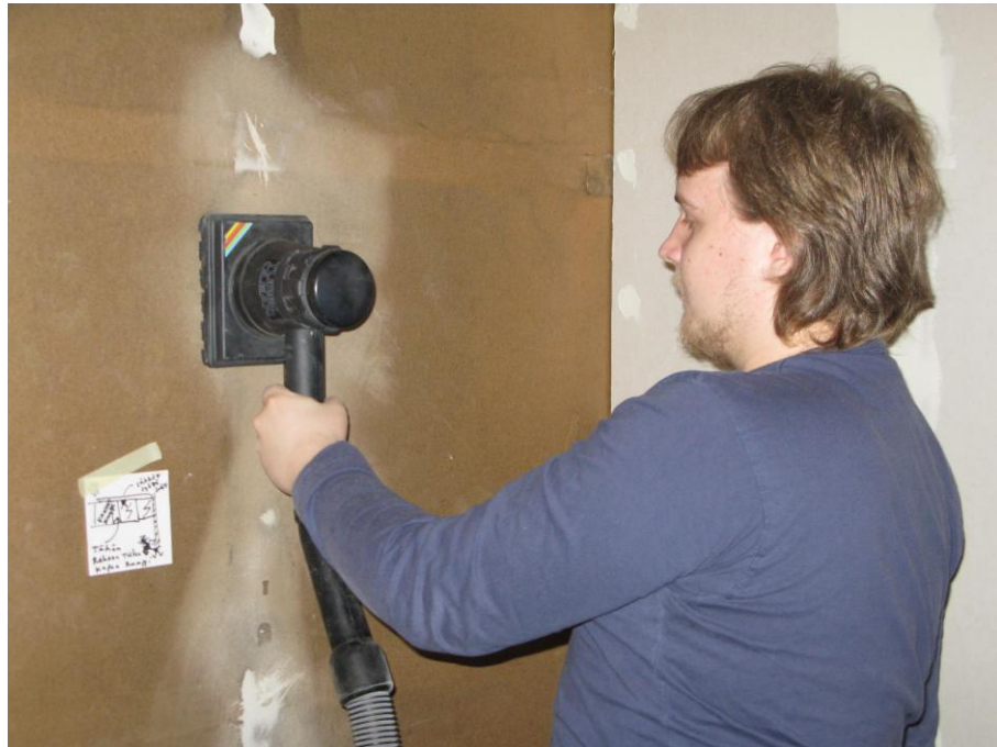
Kuva 7. Kipsiseinien ja -kattojen kittausten hiontaan soveltuva laite
