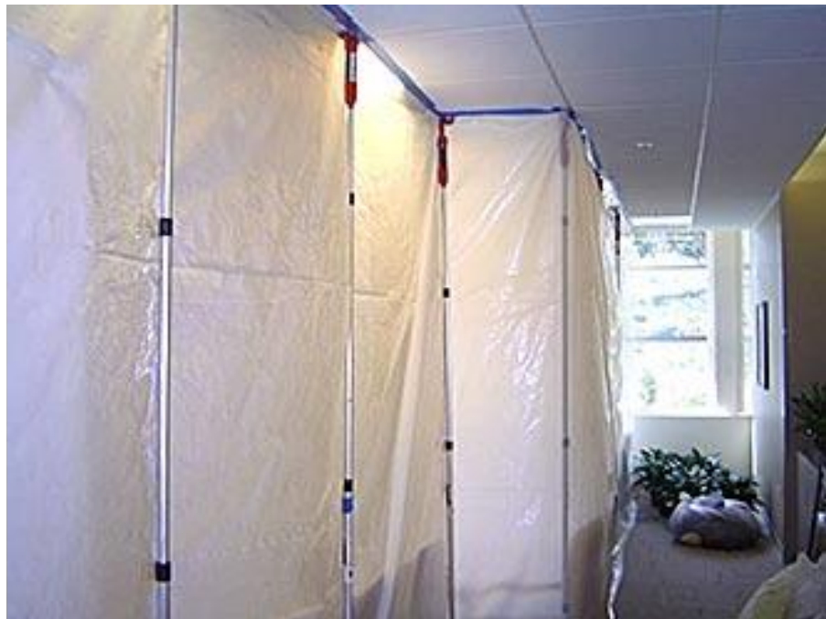
Kuva 10. Teleskooppitukien varaan tehty suojaseinä /7/
