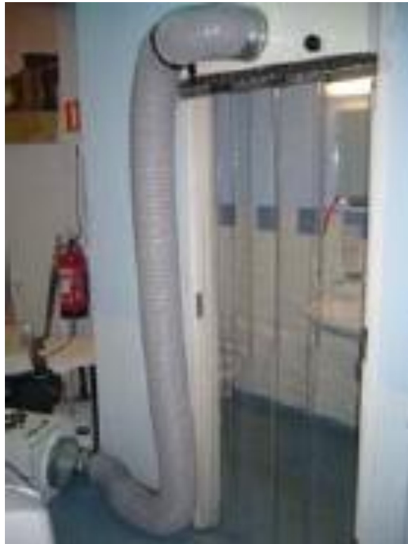
Kuva 9. Lifa Airin Innovo Reno -ovielementti on asennettu kylpyhuoneen oviaukkoon /6/
