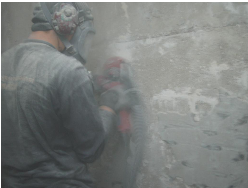
Kuva 3. Timanttihiontalaite, joka on varustettu kohdepoistolla
