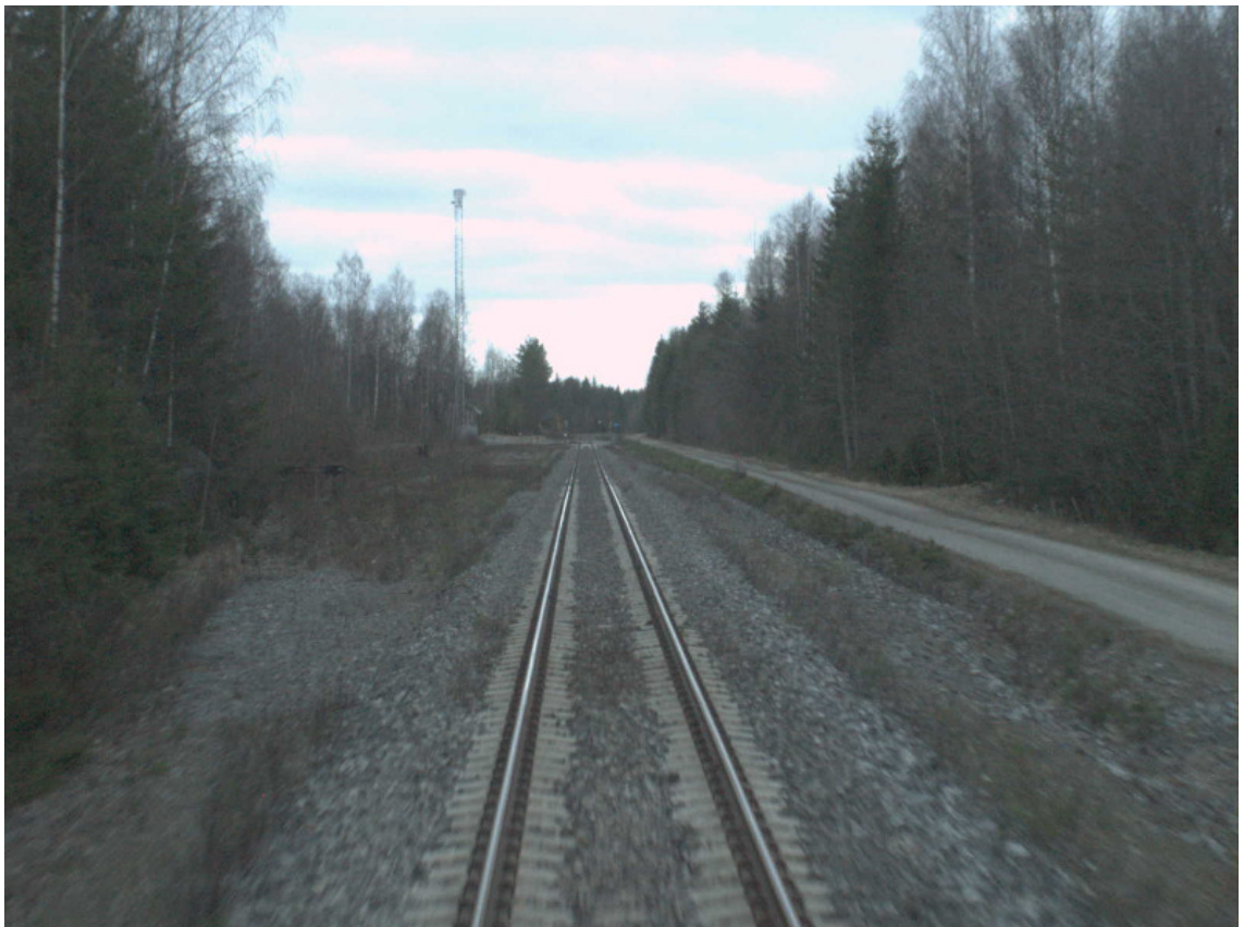
Kuva 20 Varkaus - Heinävesi Km 452+479
