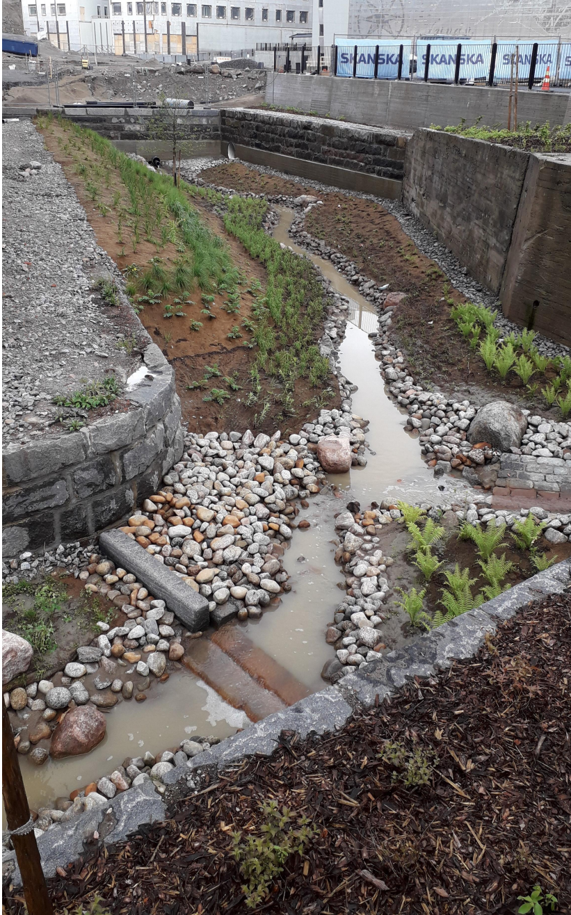
Kuvio 9. Hulevesiä viivyttävä, imeyttävä ja puhdistava rakennettu hulevesikanava Jyväskylässä Kankaan kaupunginosassa. (Schulte-Tiggas Anu 2019.)
