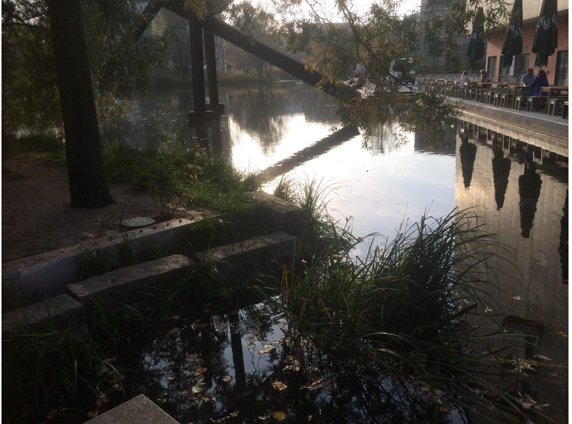
Kuvio 10. Potsdamer Platzin hulevesien viivystys- ja varastointiallas (Schulte-Tiggles Anu 2017.)
