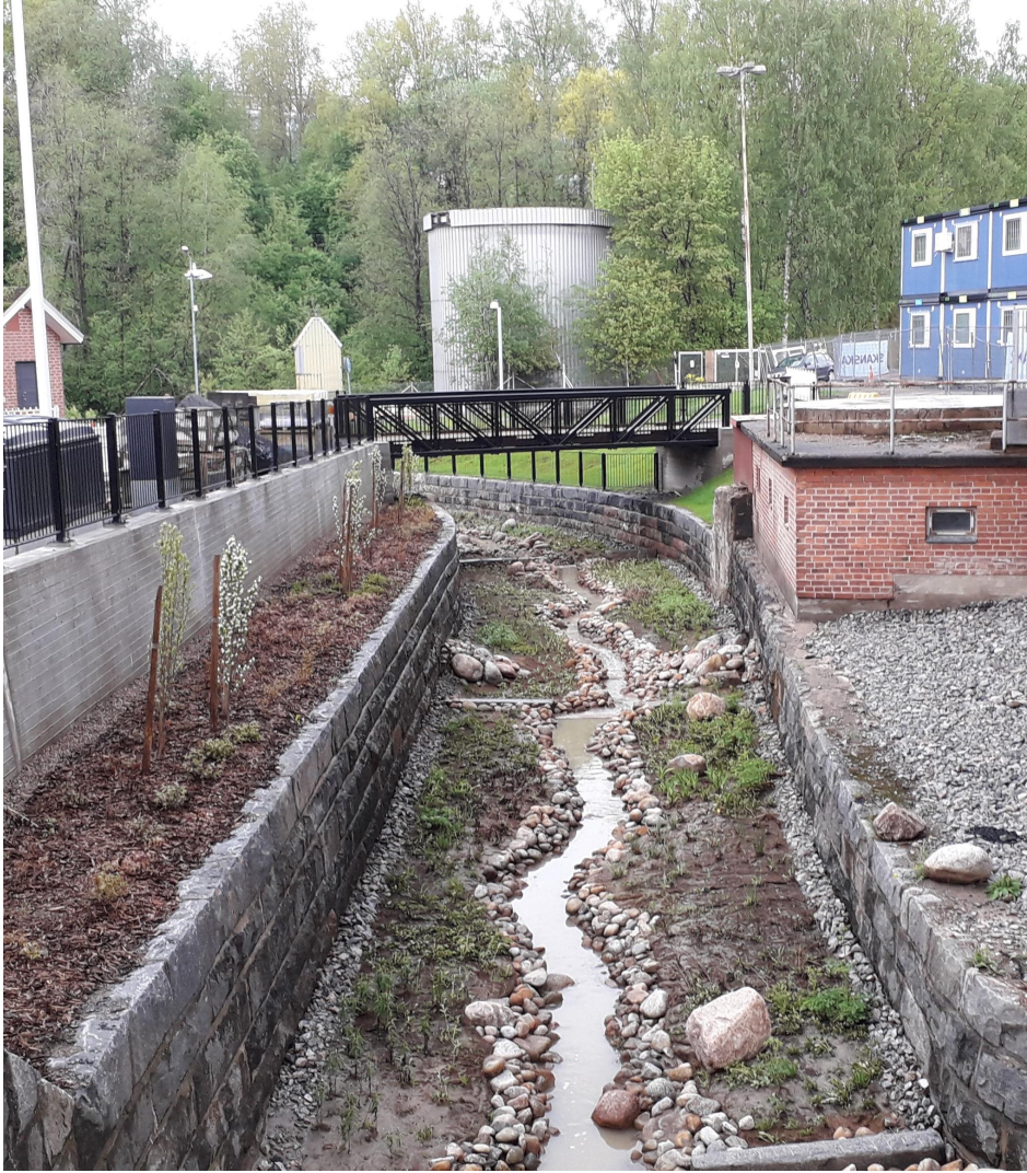
Kuvio 8. Rakennettu hulevesikanava Jyväskylässä Kankaan kaupunginosassa. (Schulte-Tiggas Anu 2019.)
