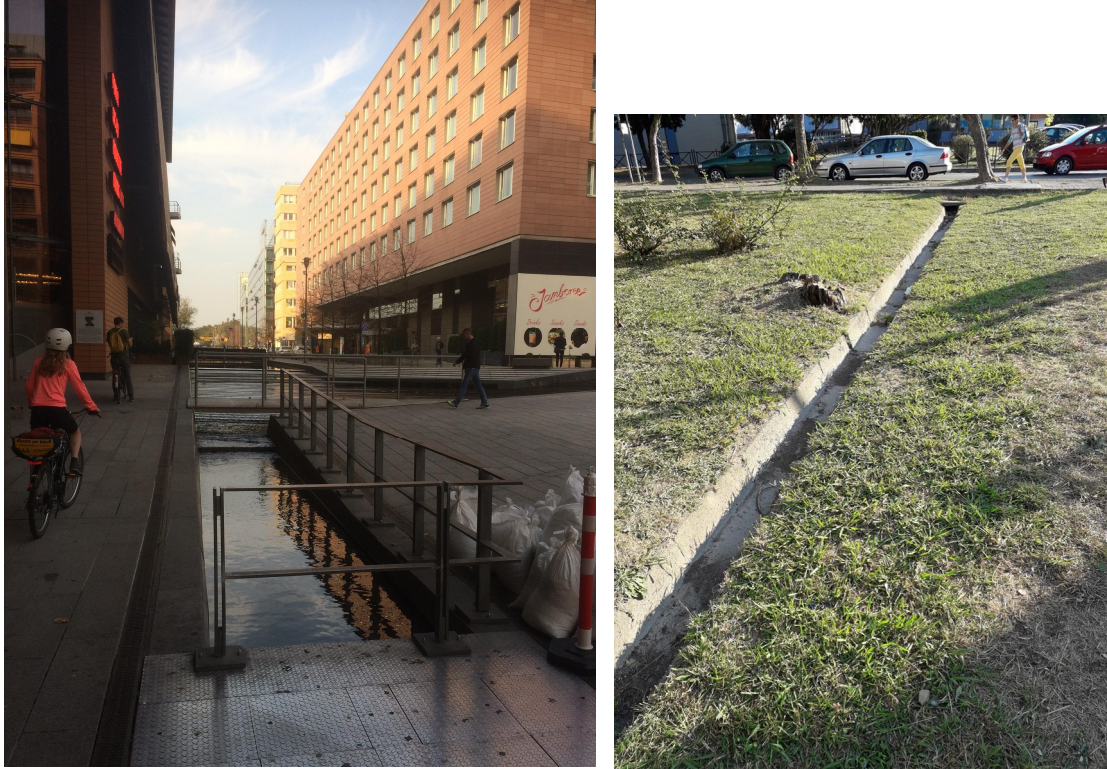
Kuvio 7. Hulevesien johtamiseksi eri aikaisia rakennettuja kanavia; vasen: Berlin, Potsdamer Platz, oikea: Montenegro, Budva. (Schulte-Tigges Anu 2019.)
