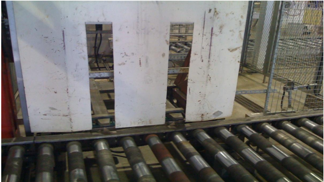
Kuva 5 Kuvassa on lavausrobotin jälkeinen lavausnosturi.
