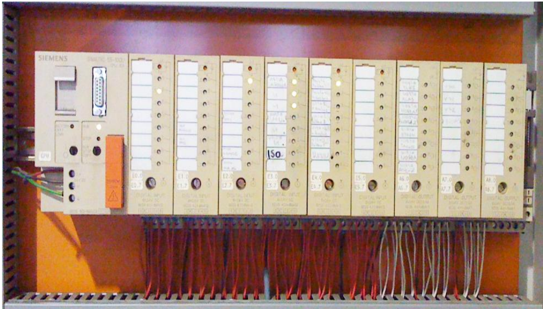
Kuva 7 Kuvassa on lavaajarobotin Siemens S5-100U CPU ja IO-kortit.
