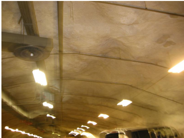
Kuva 11. Halli 1, toimii autojen varasto- ja parkkipaikkana.
