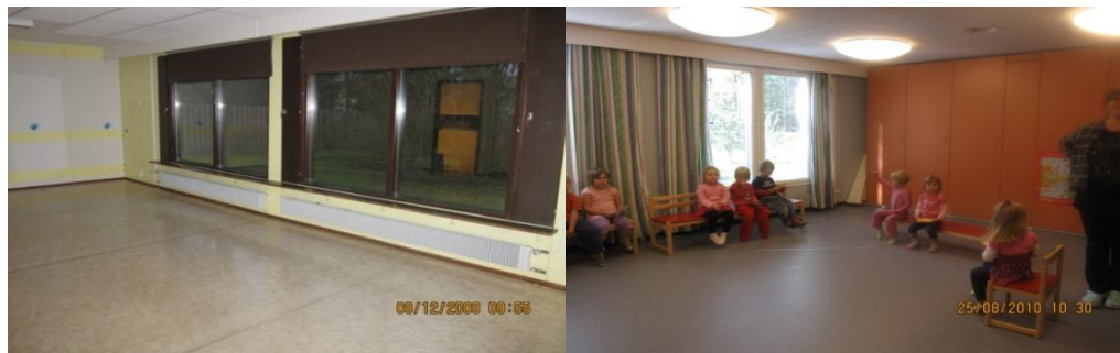
KUVA 5. Ryhmähuone ennen ja jälkeen saneerauksen (Kuva: Anna-Stiina Välimäki 2010)
