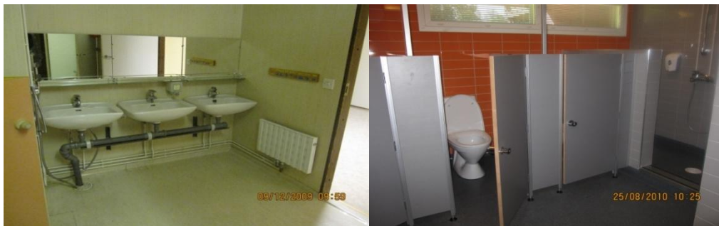
KUVA 3. Saniteetitila ennen ja jälkeen saneerauksen (Kuva: Anna-Stiina Välimäki 2010)
