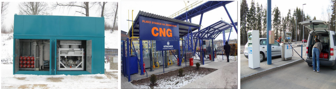
Kuva 12. Nopeatankkausasemia 20–600 Nm 3 /h
