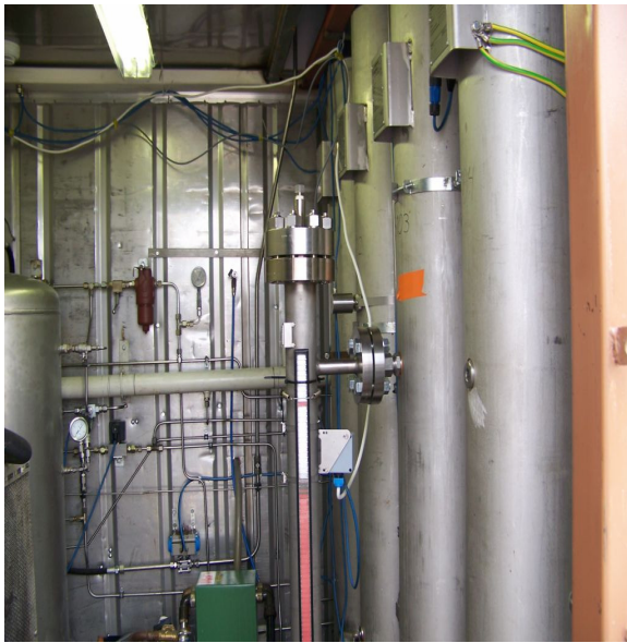
Kuva 9. Biokaasun puhdistuslaitteisto
