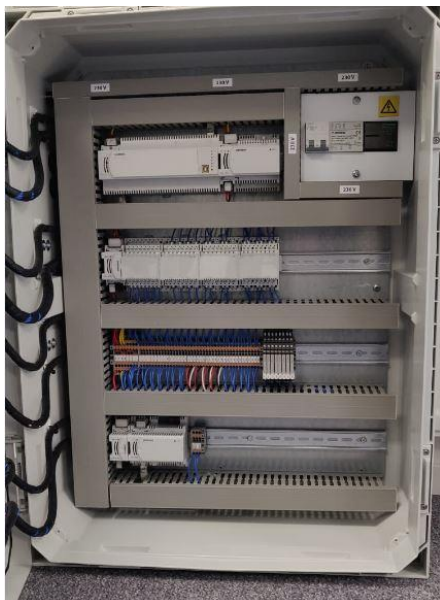
Kuvio 28. Valmiiksi kytketty testauslaitteisto
