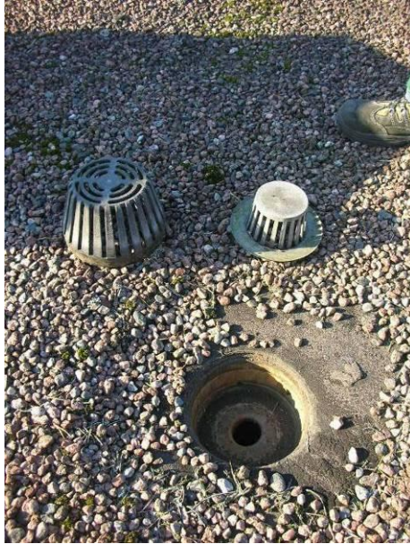
Kuva 13, Irtonaista suojakiveystä kaivon ympärillä /20/.
