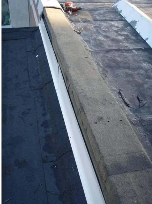
Kuva 10, Avattu räystäsrakenne kuntotutkimuksessa /20/.
