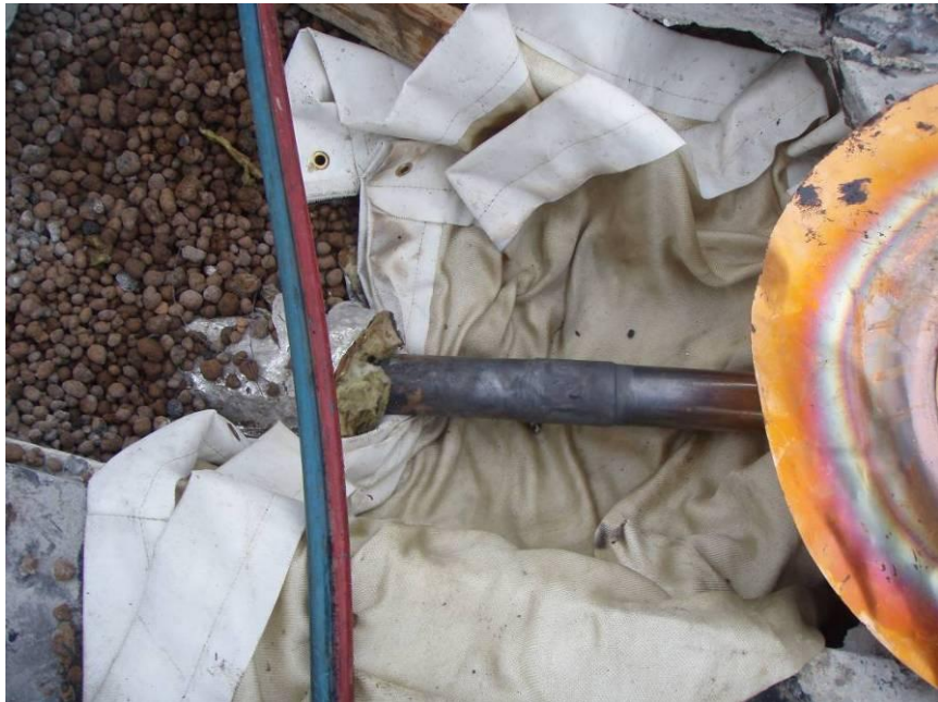
Kuva 32, Uusi putki liitettiin vaakalinjastoon hitsaamalla.
