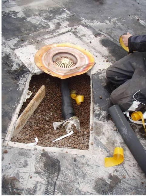
Kuva 33, Putki eristettiin Armaflex-putkieristeellä ja vanhat rakenteet asennettiin paikalleen.
