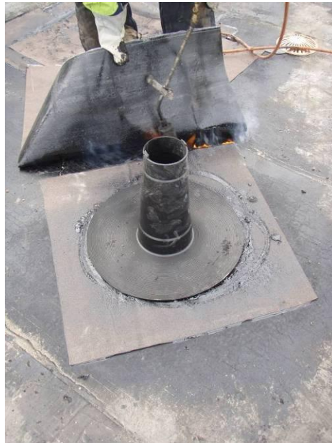
Kuva 35, Vuotokohdan läheisyyteen asennettiin alipainetuuletin nopeuttamaan rakenteiden kuivumista.
