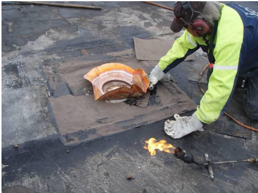
Kuva 34, Uusi kaivo tiivistettiin oikeaoppisesti kermien väliin.
