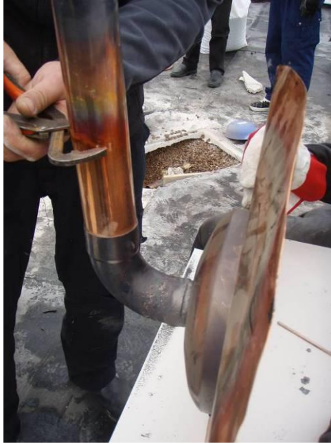
Kuva 31, Työvaihe, jossa uusi putki liitetään uuteen kaivoon.
