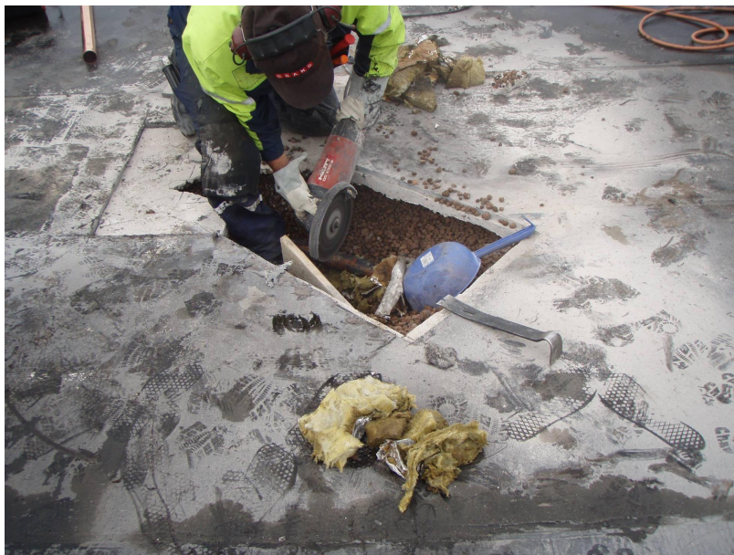
Kuva 14, Putkilinjaa pitkin tehty rakenneavaus, vesivuotoselvitys.
