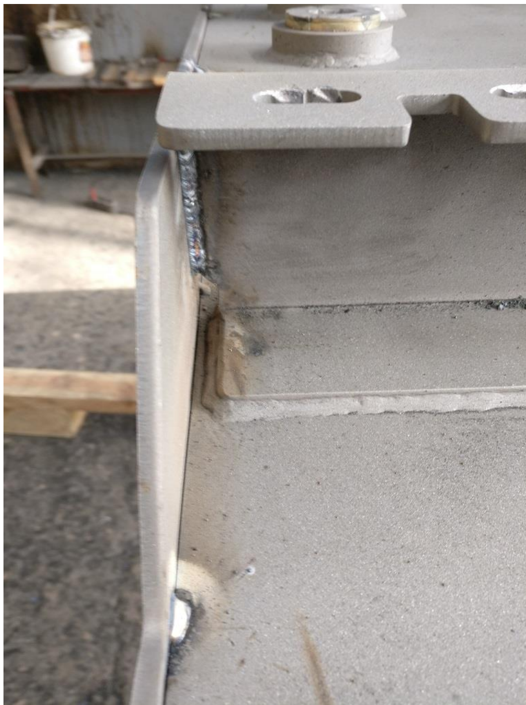
KUVA 10 Teräslevynpinta suihkupuhdistuksen jälkeen
