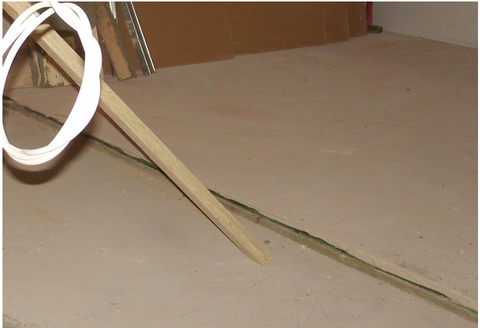
Kuva 7.10 Takana uutta lattiapintaa. Pumpattu kipsimassa, suojapaperi ja 30 mm askeläänivillaa. Rakenne on erotettu seinästä reunakaistalla. Edessä tulevan kylpyhuoneen lattian kohta.(Kuva J. Wikström)
