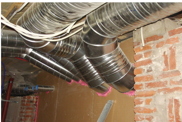
Kuva 2.3 Lähes valmis EI120 rakenteinen seinä IV-konehuoneen ja huoneiston b22 välillä. (Kuva J. Wikström)
