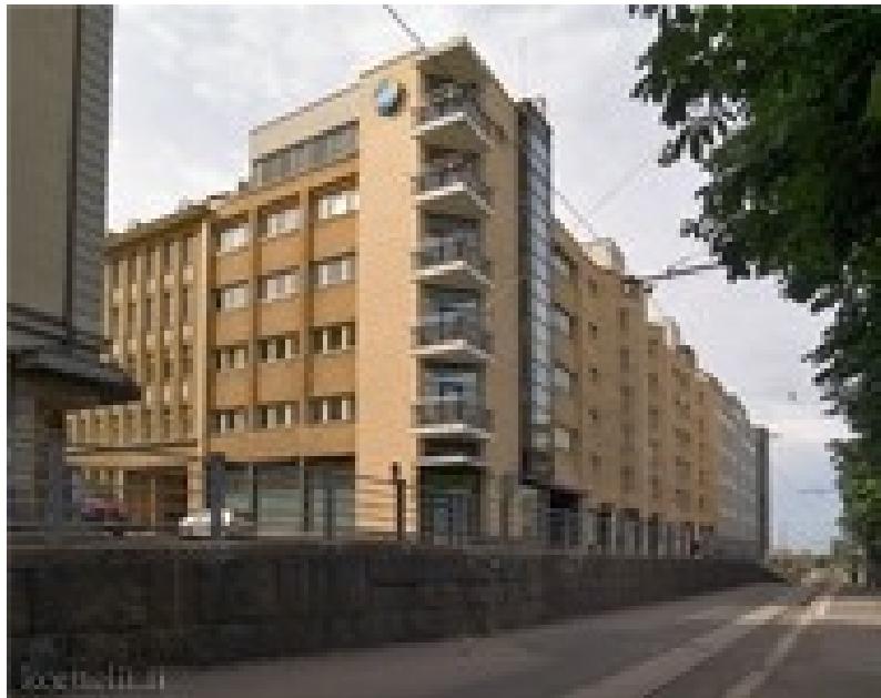
Kuva 2.1 Yleiskuva Kiinteistö Oy Köydenpunojasta. (11)
