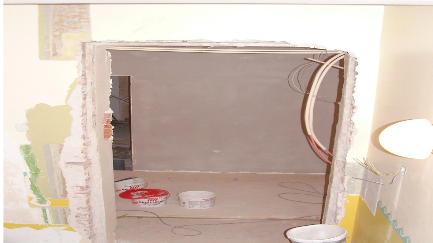
Kuva 3.1 Neljännen kerroksen hissitasanteen uusi oviaukko. (Kuva J. Wikström)
