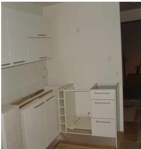
Kuva 7.1 Puolivalmis keittiö (Kuva J. Wikström)
