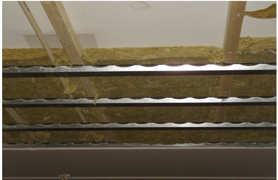
Kuva 7.9 Katon asennustyö menossa. Tässä kohdassa ei poikkeuksellisesti ole näkyvillä sähköasennuksia.(Kuva J. Wikström)
