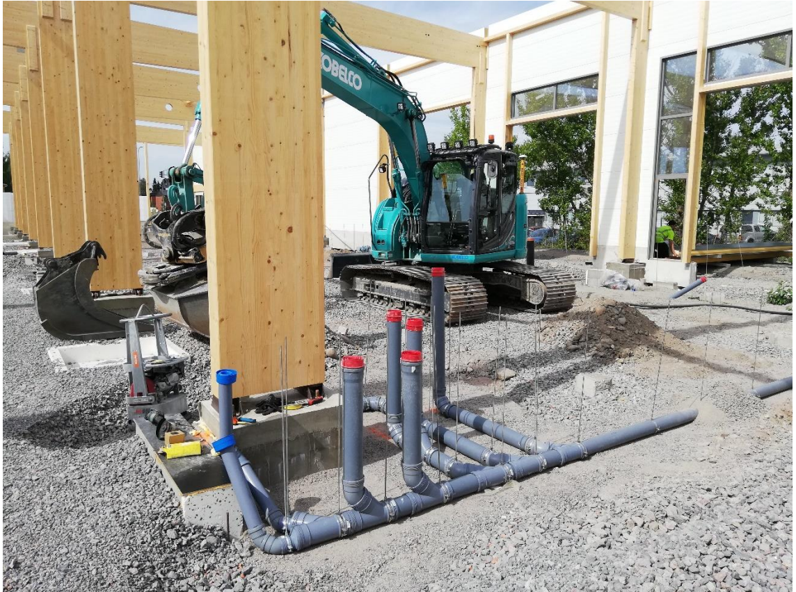
Kuva 8. Katvealue työmaalla (Tiihonen 2018)
