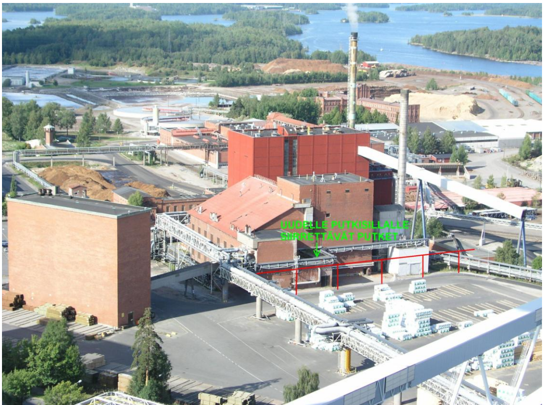
Kuva 29. Uusi putkisilta
