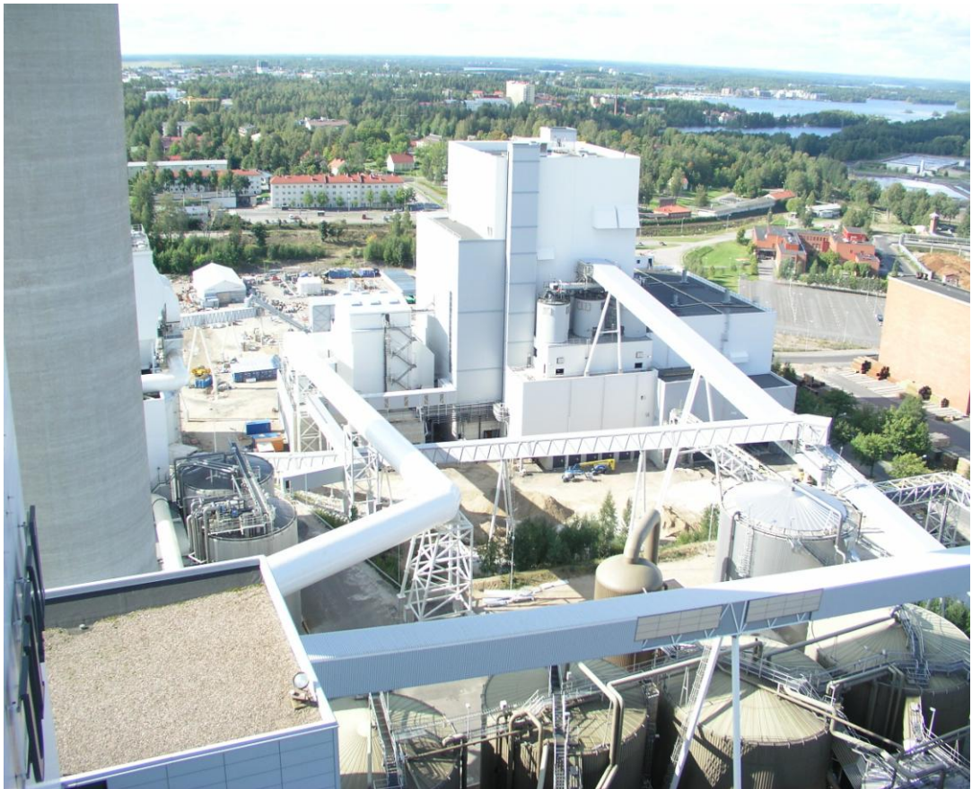
Kuva 2. Kaukaan Voima Oy:n biovoimalaitos rakenteilla
