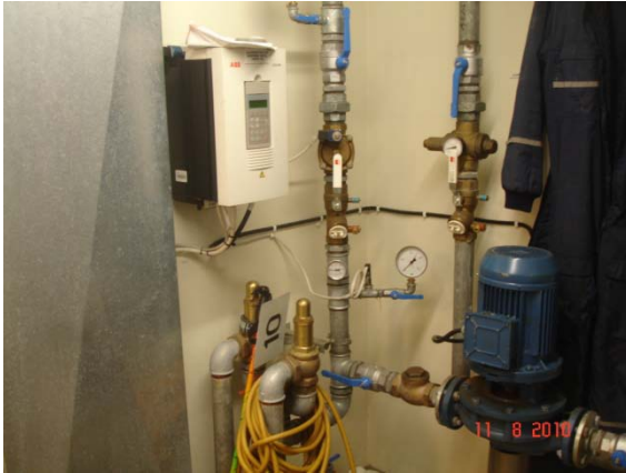
Kuva 6. Paineenkorotuspumppu k120
