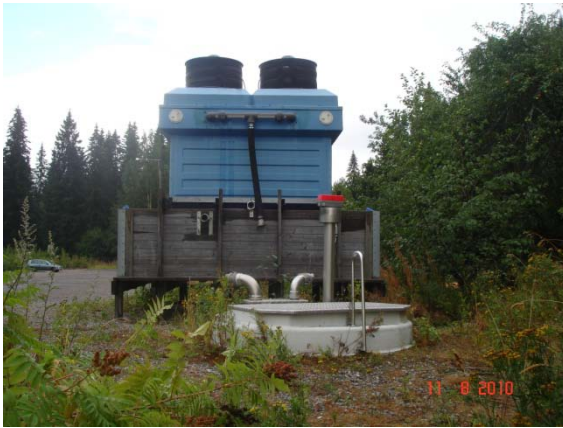
Kuva 17. Lumetusjärjestelmän lauhdutin
