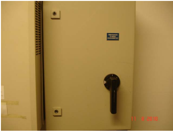
Kuva 9. Hissin Päävirtakytkin
