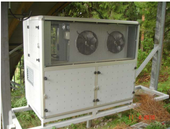
Kuva 5. Ylämäen jäähdytyskone
