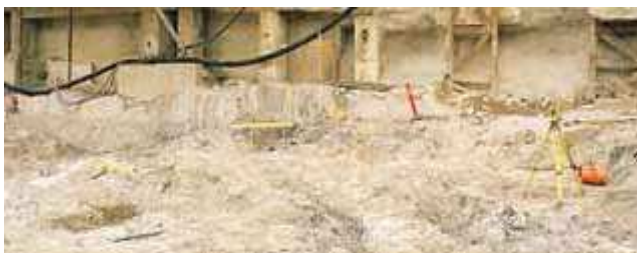
Kuva 3.3. Tennispalatsin perustusten louhinta
