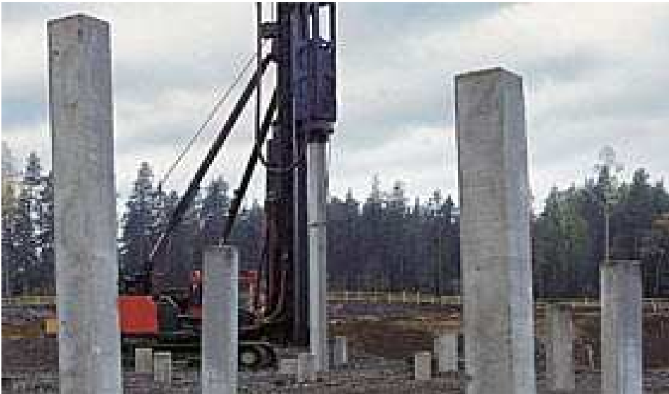
Kuva 3.4. Paalutustyö, paalut juntataan ennakkoon mitattuihin ja merkattuihin paikkoihin. (Rudus)
