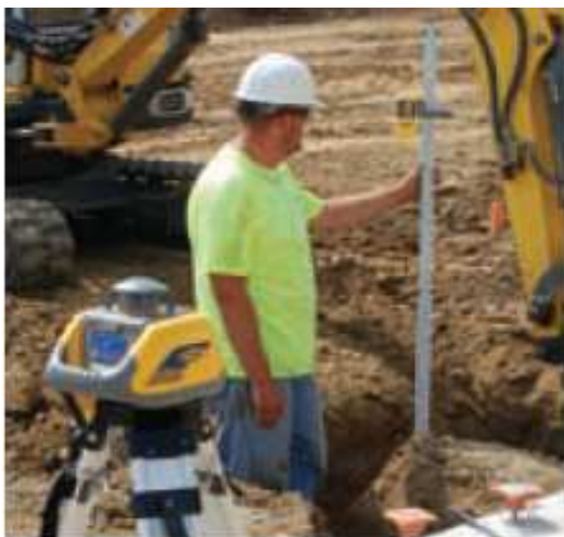
Kuva 3.2. Putkikaivannon mittausta tasolaserilla, jossa kallistuksen säätö (Spectra presion laser)
