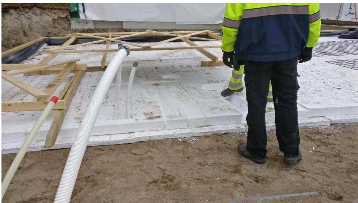
KUVA 2. Elementtien asennukseen rakennettu sapluuna (Savola 2018-06-06)
