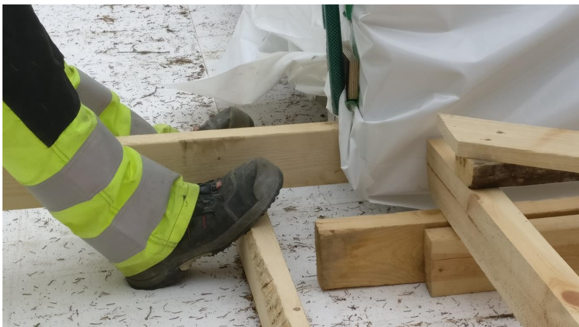
KUVA 3. Elementtiä painetaan asennus sapluunaa vasten (Savola 2018-06-06)
