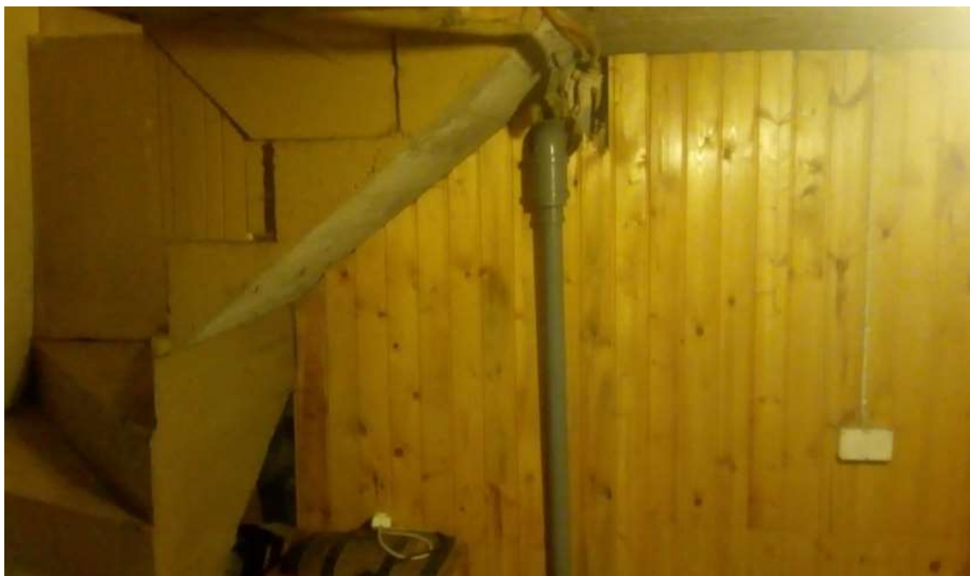
Kuva 7. Suihkutilojen viemäriputki kellarikerroksessa - (Kankkunen 2019-03-15)
