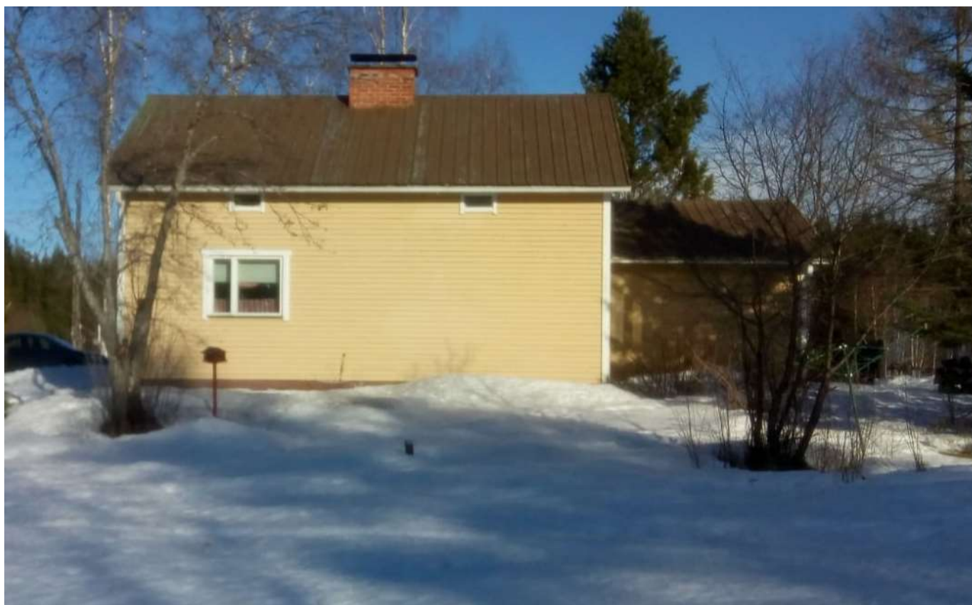
Kuva 11. Valokuva julkisivusta länteen - (Kankkunen 2019-03-15)
