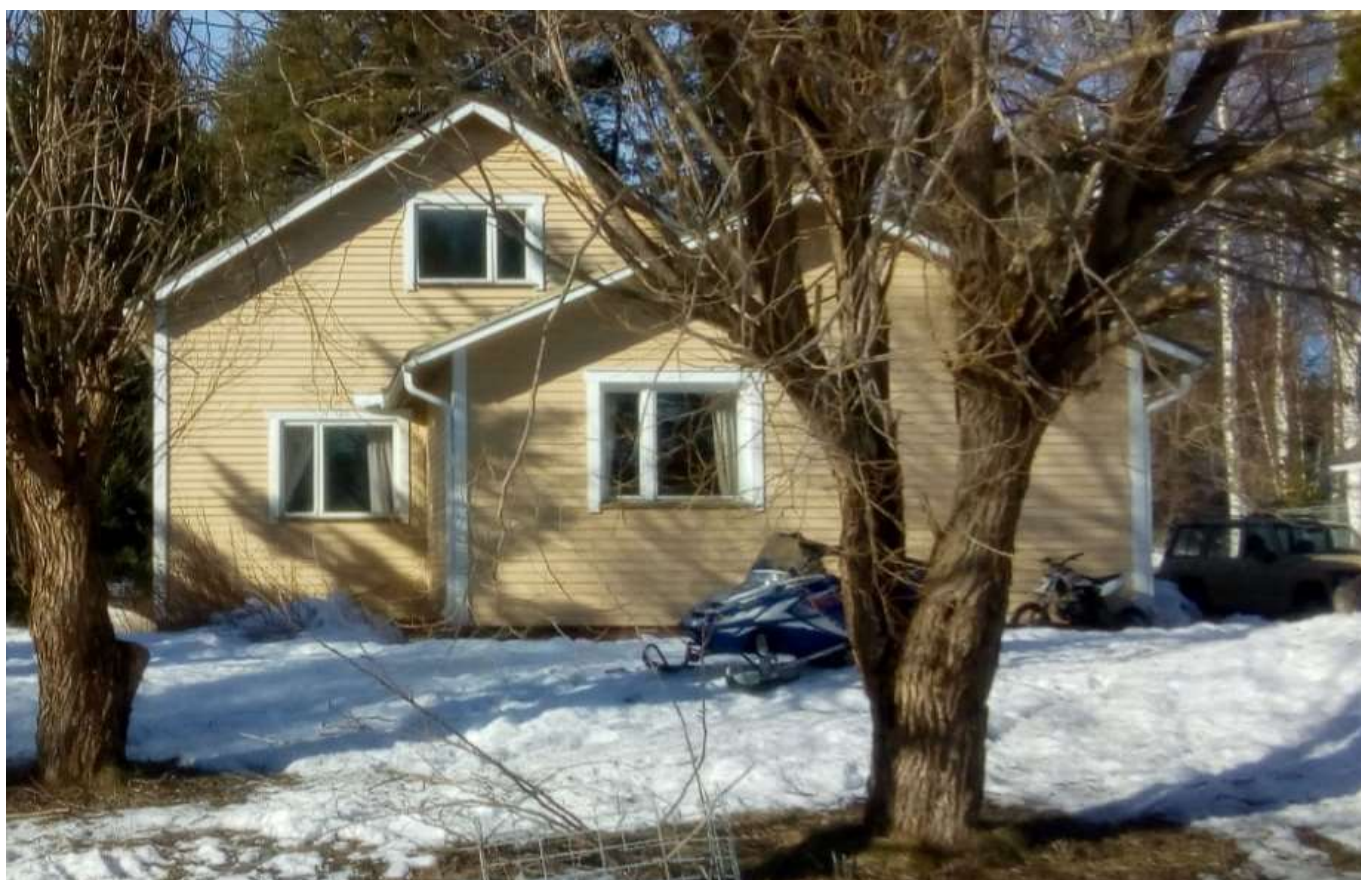
Kuva 9. Valokuva julkisivusta etelään - (Kankkunen 2019-03-15)
