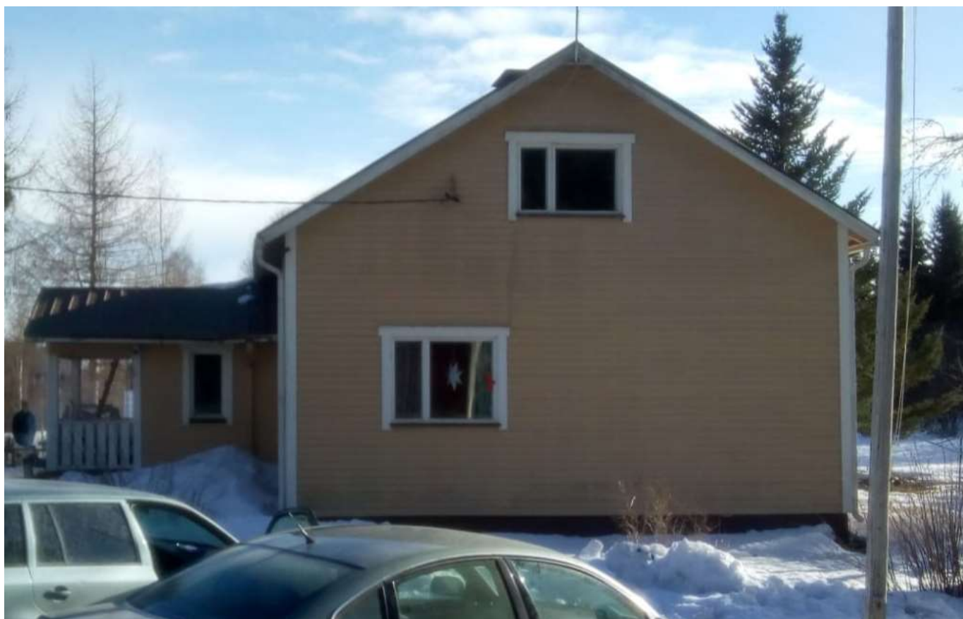
Kuva 13. Valokuva julkisivusta pohjoiseen - (Kankkunen 2019-03-15)
