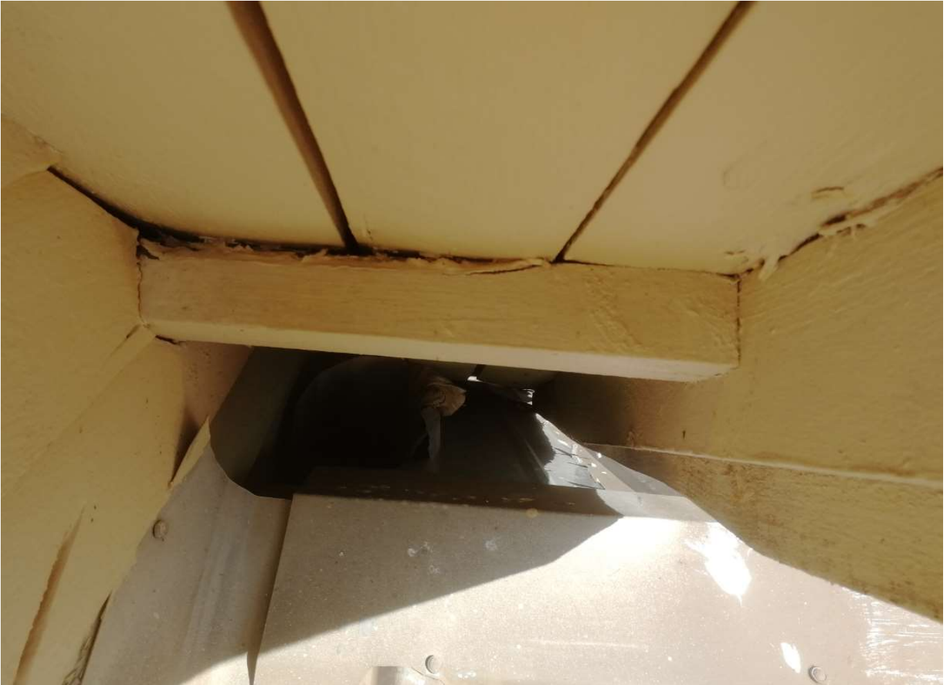
Kuva 17. Kuva riskirakenteesta räystäään alta - (Kankkunen 2019-04-19)
