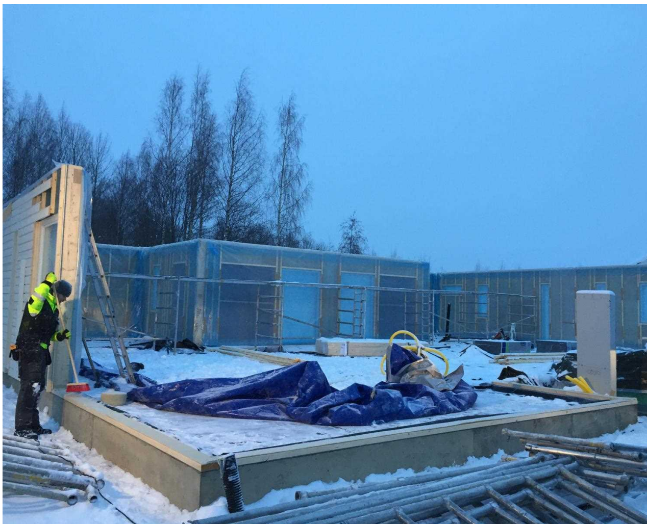
Kuva 9. Elementin asennusta työmaalla (Kolari 2019)
