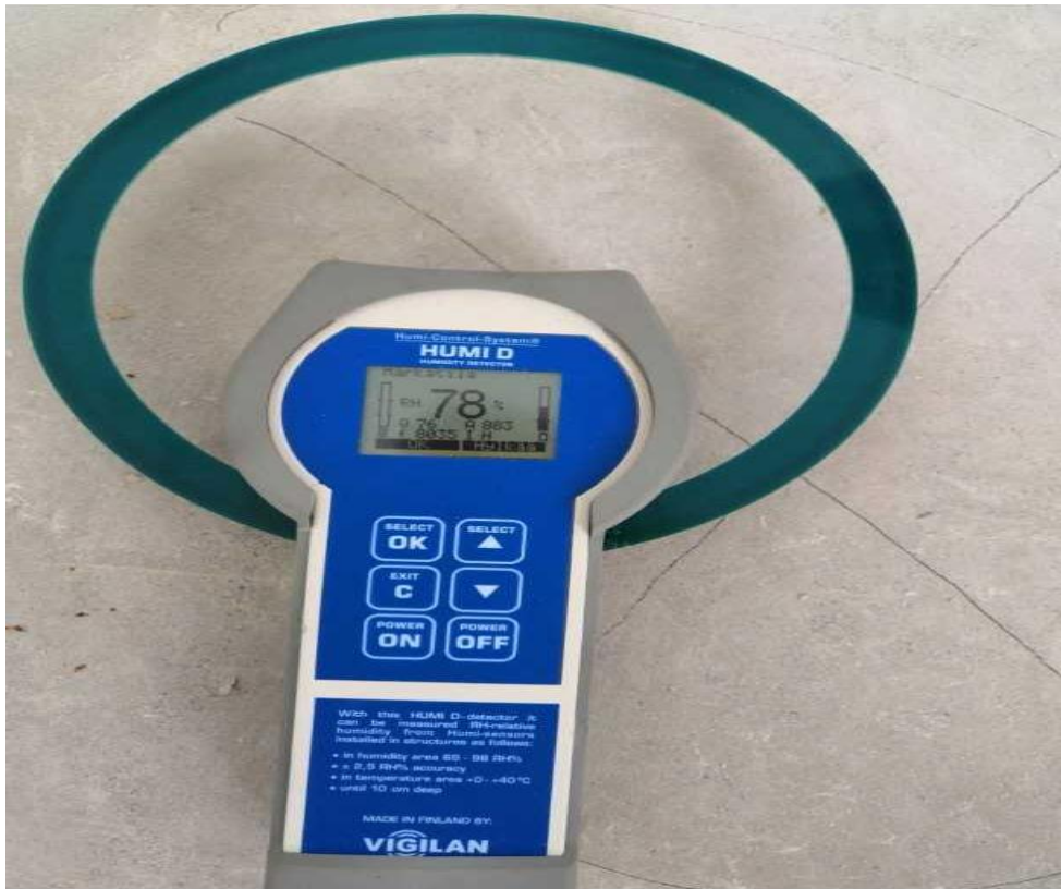
Kuva 11. Betonin suhteellisen kosteuden mittaamista kohdetyömaalla (Kolari 2019)
