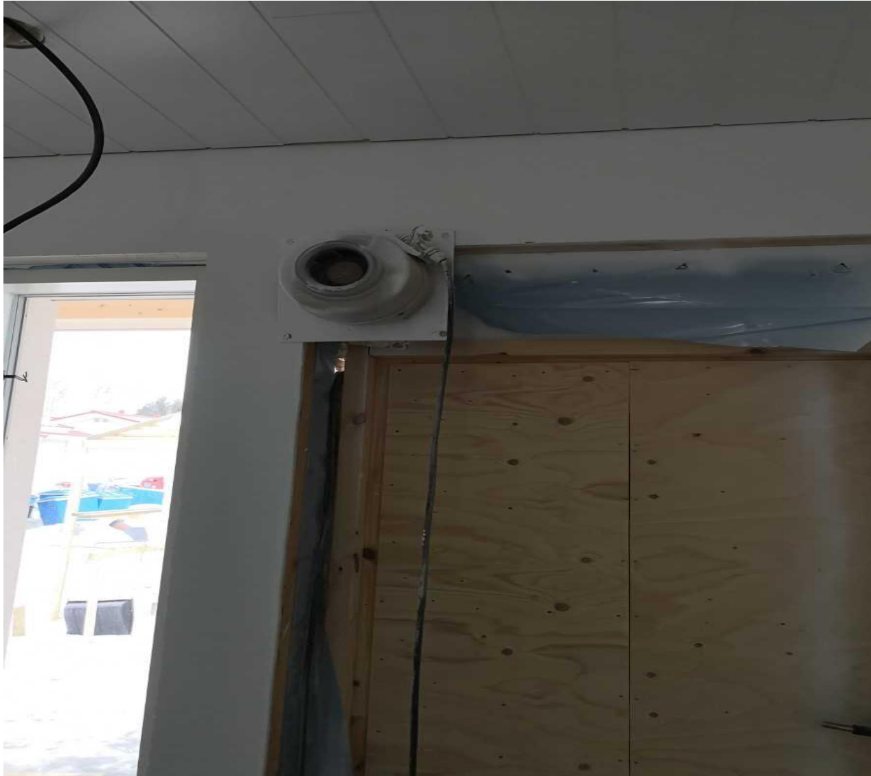
Kuva 10. Kanavapuhallin kohdetyömaalla (Kolari 2019)
