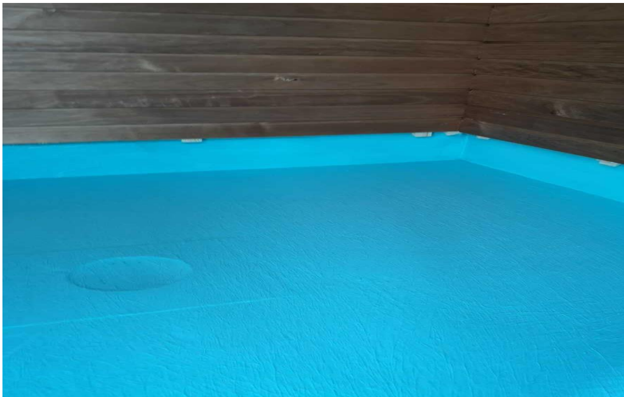
Kuva 4. Vesieristetty saunan lattia (Kolari 2019)
