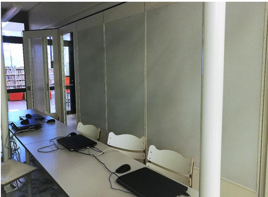
Kuva 4. Mediateekkien avattava väliseinä ja kulkuyhteys kirjastoon
