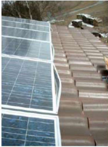
Kuva 2. Taipuneita aurinkopaneelien alumiinikehyksiä. (Herfurth & Tost 2010)
