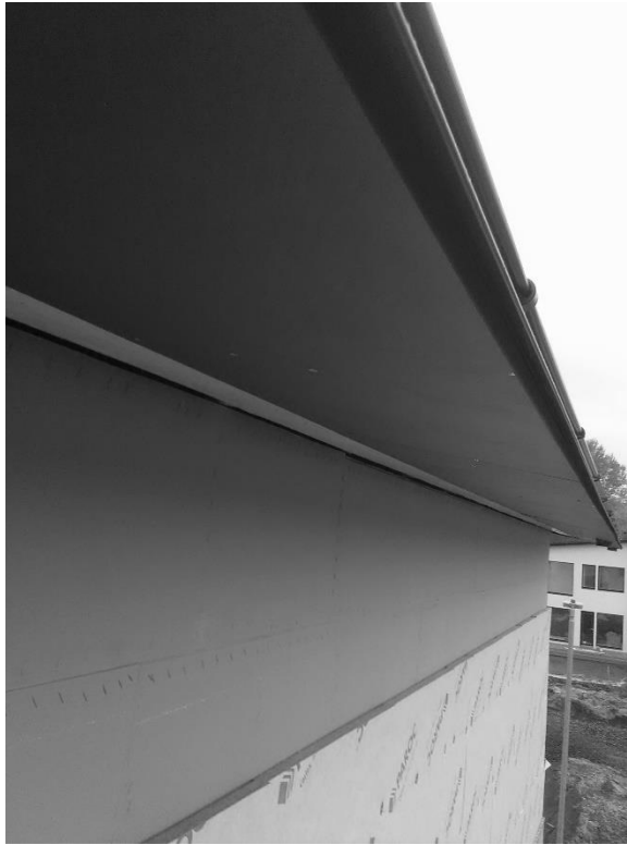
Kuva 10. Kohteen räystäään valmis palo-osastointi
