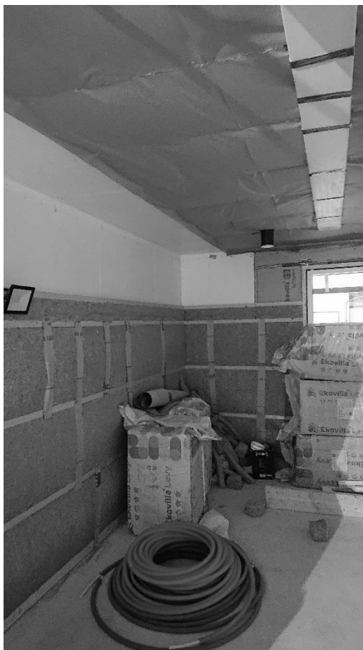
Kuva 5. Palo-osastointi sisäpuolista paloa vastaan
